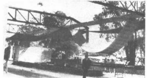
Un aspecto del montaje de las láminas colgantes.
