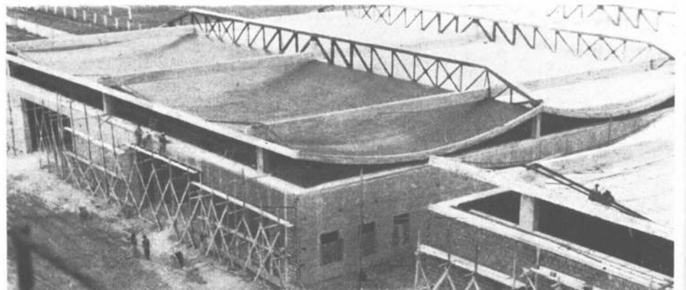
Vista aérea de las láminas colgantes, ya terminadas.
