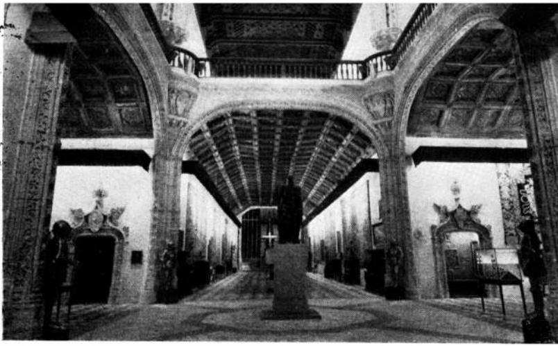
18. Toledo. Hospital de Santa Cruz (hoy museo de Carlos V); encuentro de las naves y la linterna.
