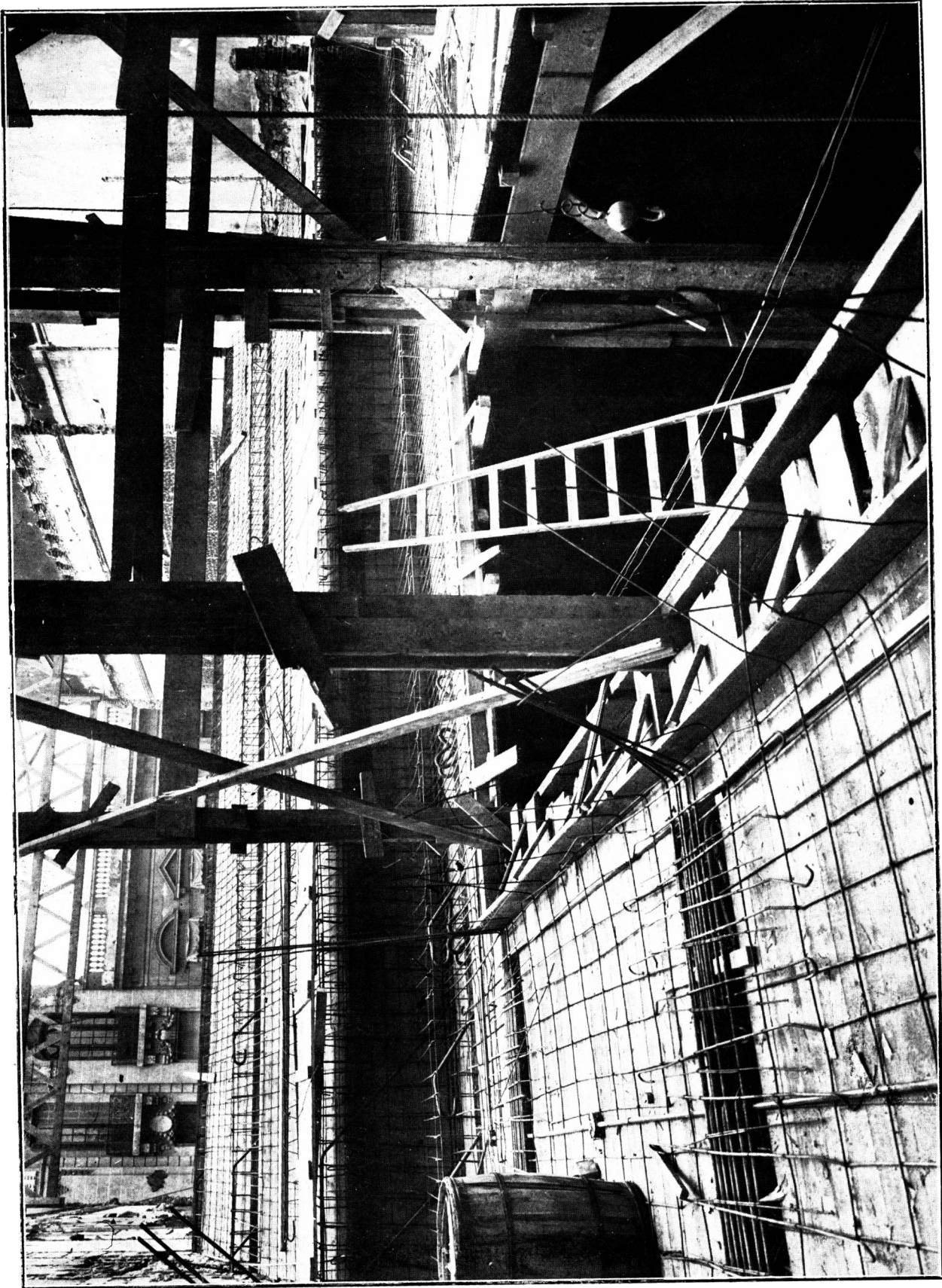
ARMAZON DE HORMIGON ARMADO Y PARTE DE LA TERTULIA
