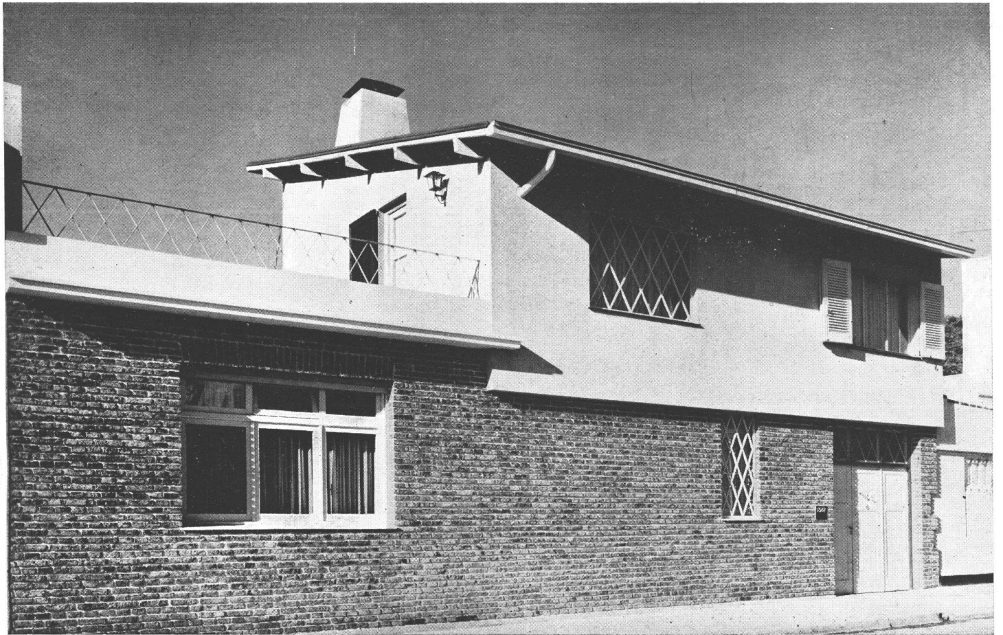
Fachada de la casa, situada en la calle Murcia 1567
