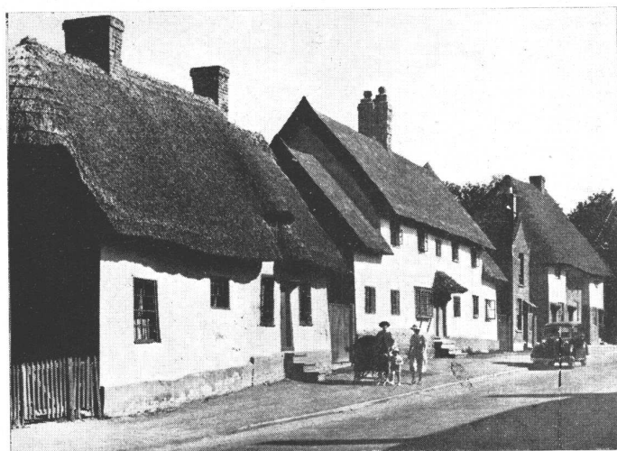
Pintorescas viviendas en una aldea situada cerca de Londres. Ellas han sido construidas con materiales de otros tiempos. Hoy los arquitectos británicos están diseñando nuevas casas que han de construirse con los materiales de que hoy se dispone.
