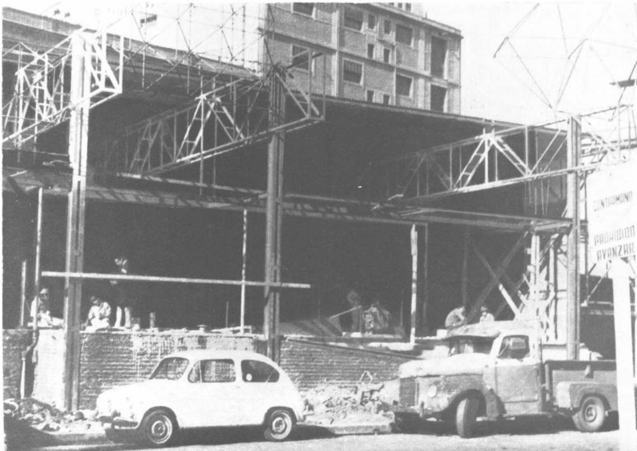
La foto muestra la estructura en obra del supermercado.
