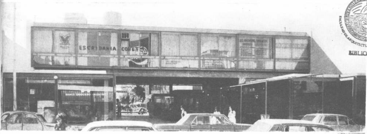
Fachada de la galería sobre la calle Adrogué.
