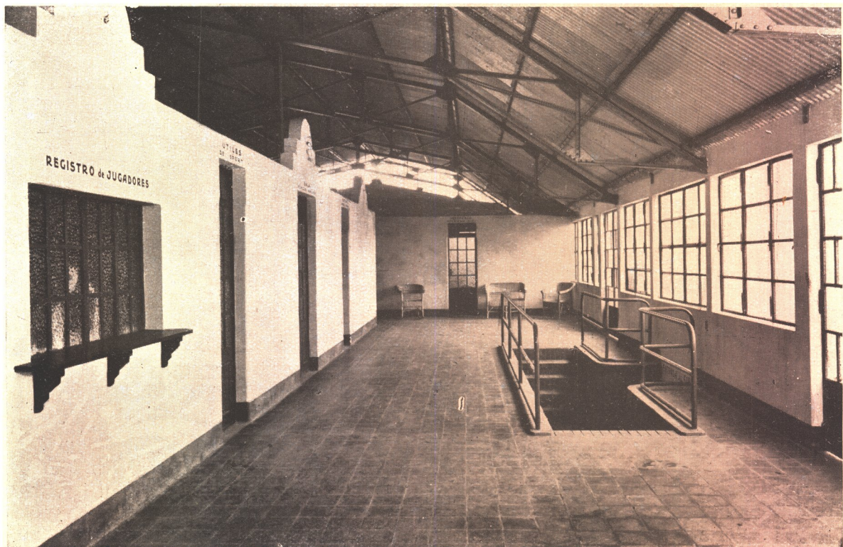
Dependencias para jugadores y entrada al pasadizo subterráneo
