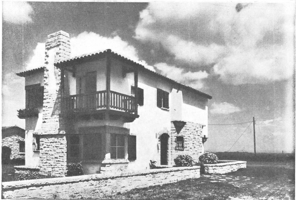
Vivienda en Mar del Plata, propiedad del Capitán de Fragata R. Fitz Simon. ARRIBA, una vista de la casa desde el jardín interior. ABAJO, vista de un ángulo de la propiedad; desde el balcón se domina la vista al mar.
