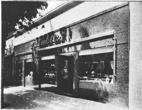
Local de ventas de la SUCESION B. E. SPINETTO Instalaciones por ROSELLO
