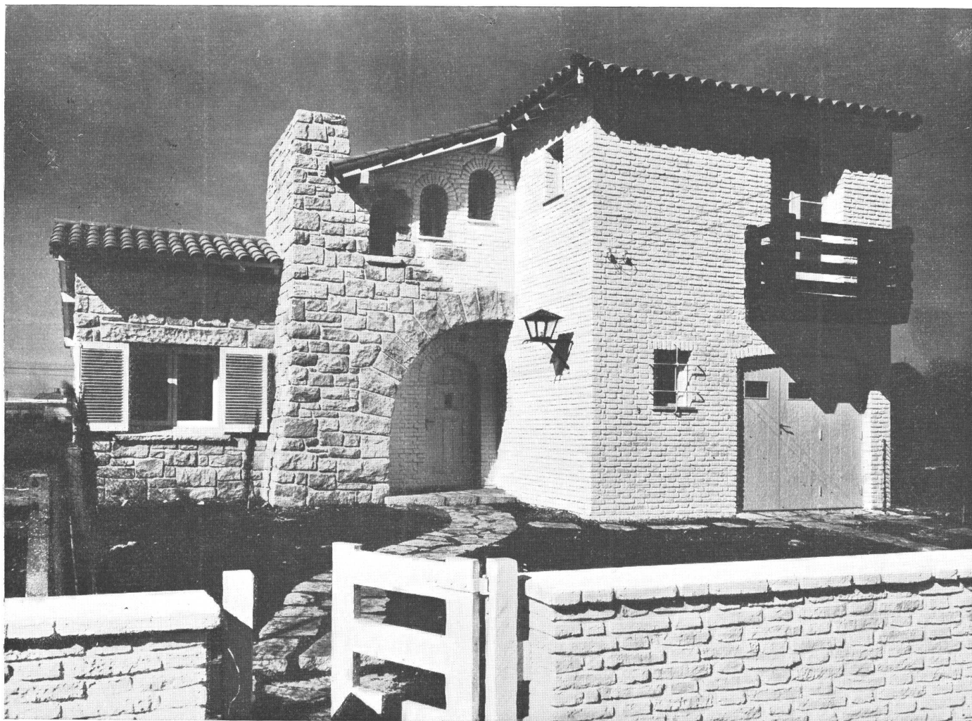
ARQS. VARGAS Y ARANDA, S.C.A. Dos chalets en Mar del Plata. Chalet B; vista general. Todo el exterior ha sido tratado en tonos claros, blanco, marfil y piedra Mar del Plata, destacándose como única mancha oscura, el balcón ejecutado íntegramente en madera.
