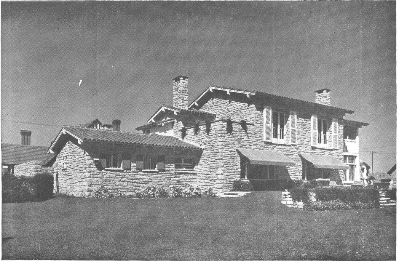
Vista del frente que mira al mar.
