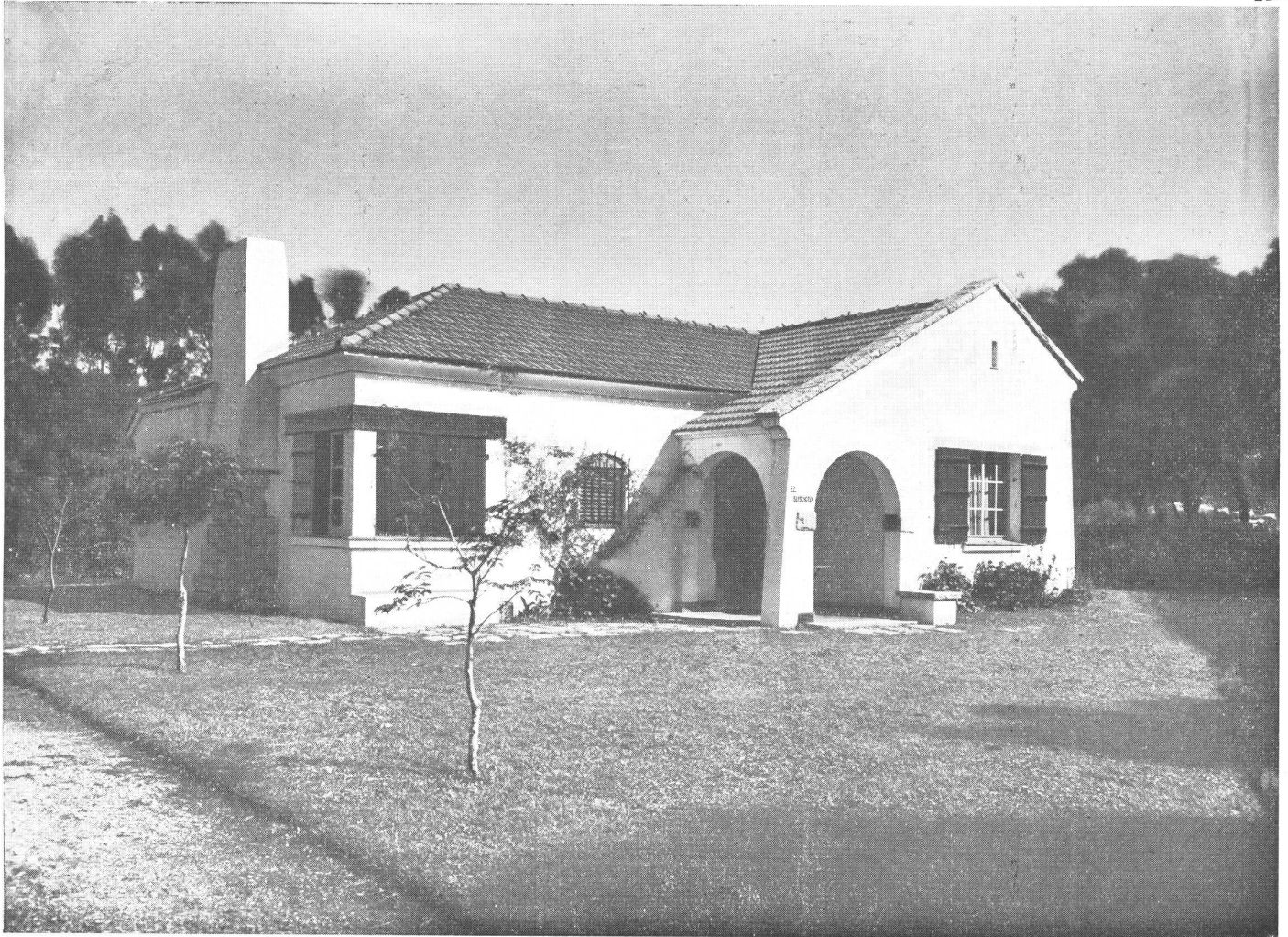
Constructora, Mar del Plata
