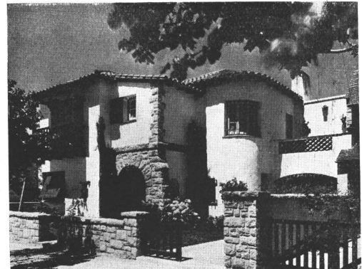
Propiedad del Sr. ROLANDO SARTORA Arq. LUIS ABERASTAIN ORO SARTORA E HIJOS - CONSTRUCCIONES Córdoba 2628 - U. T. 1206 - Mar del Plata
