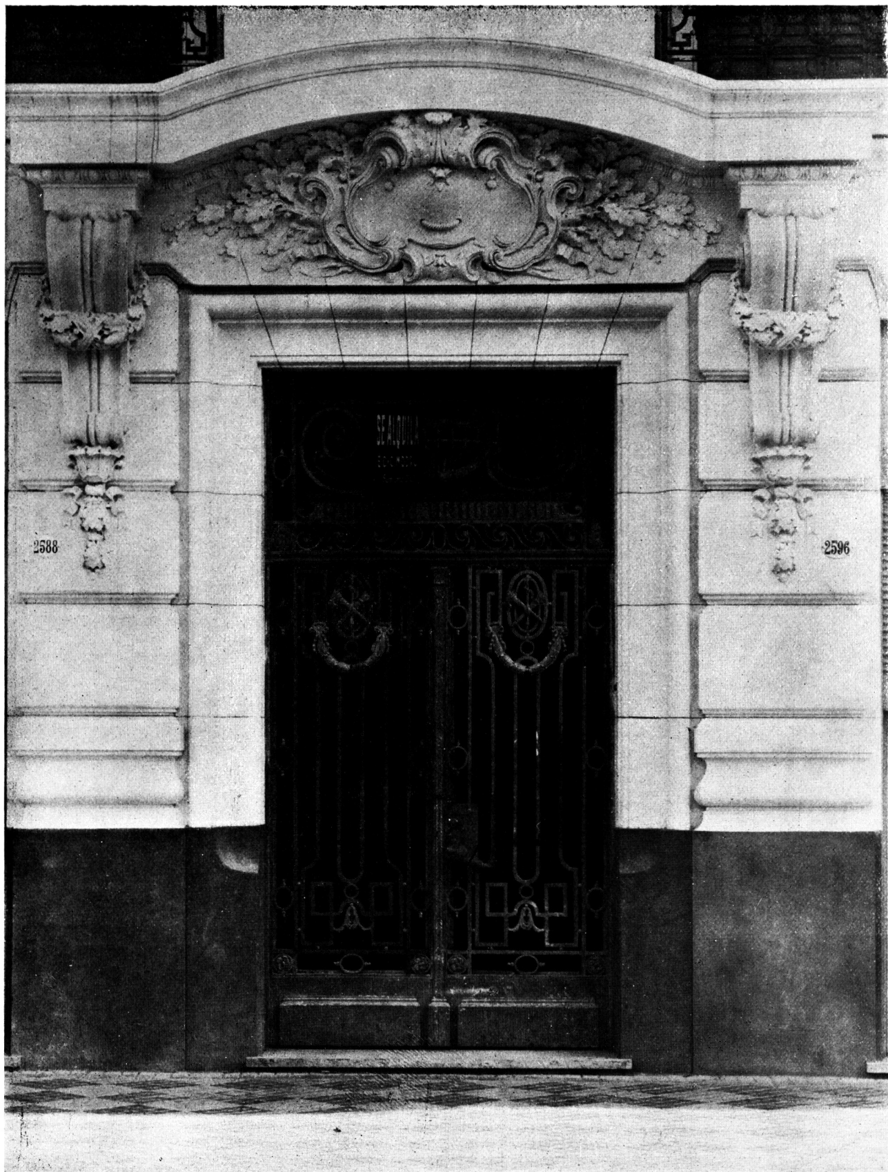
OBRA LAVALLE Y PASO: DETALLE DE UNO DE LOS PORTONES
