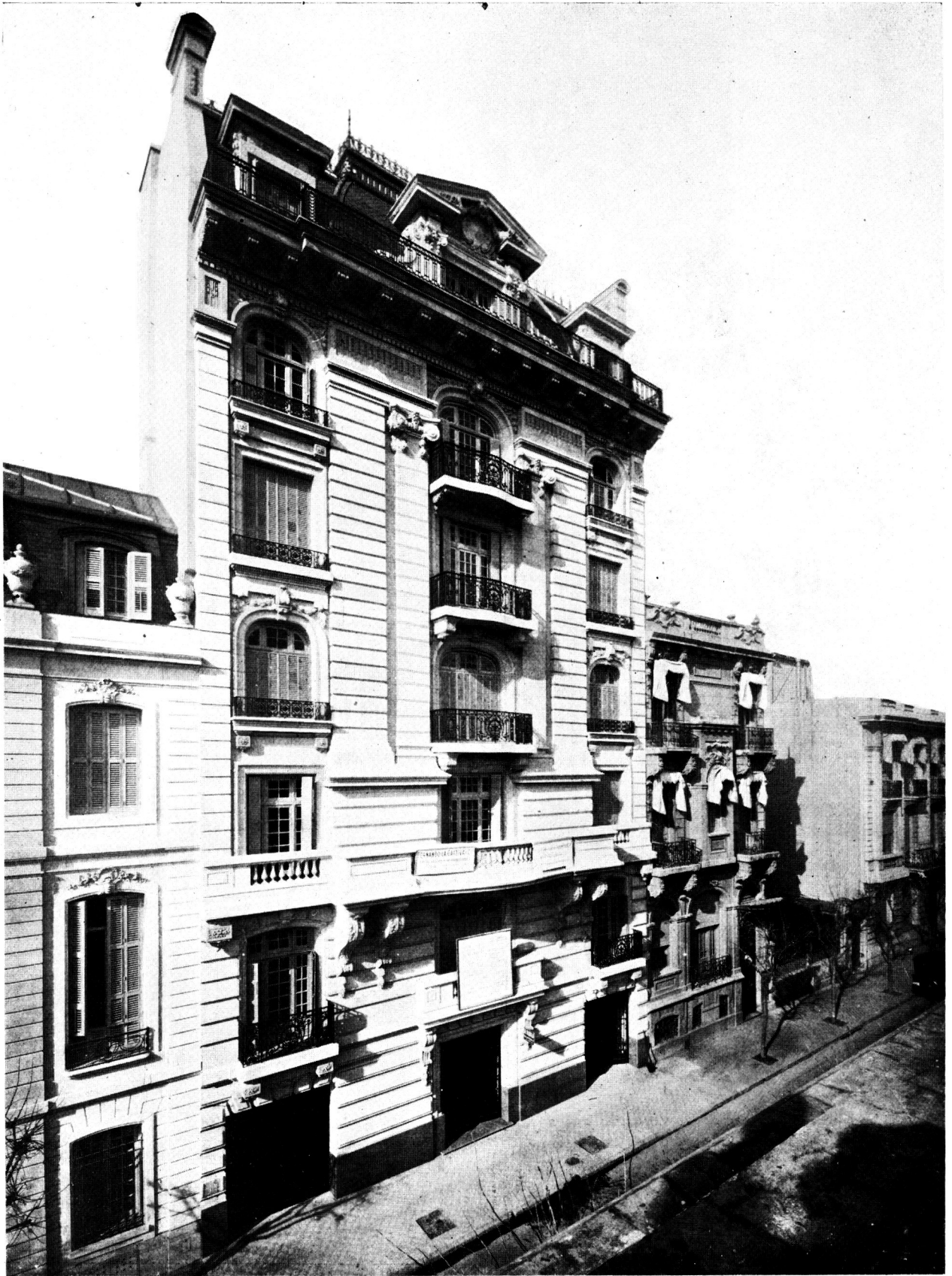
OBRA MONTEVIDEO 1640: FACHADA
