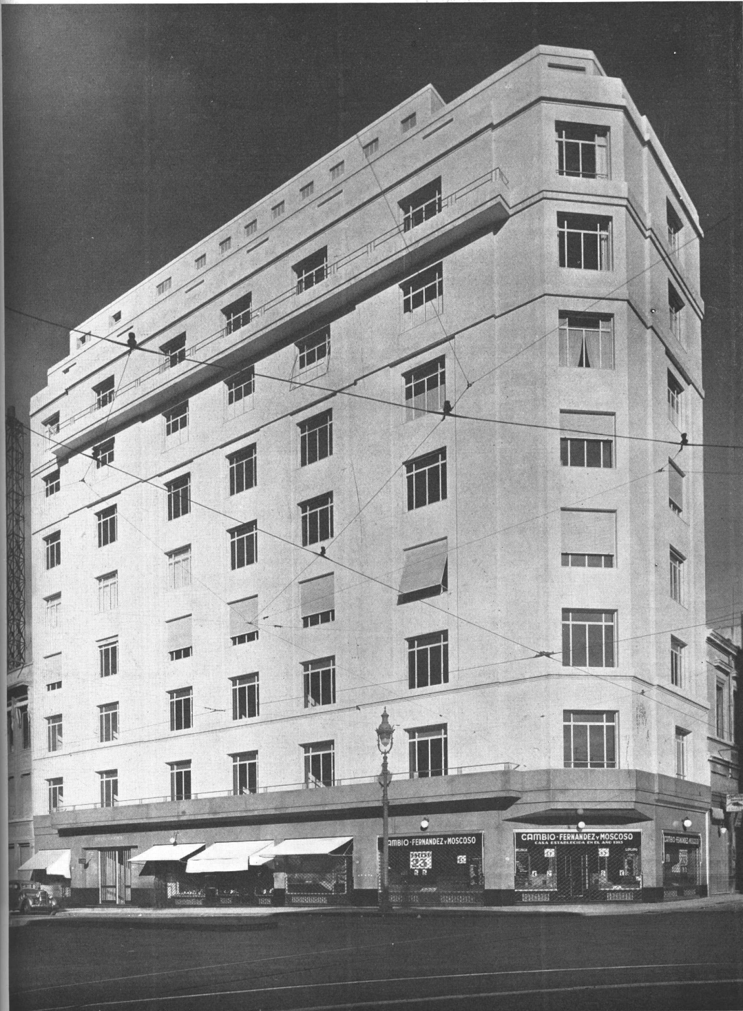
Vista del frente del edificio, situado en Avda. Corrientes y Reconquista
