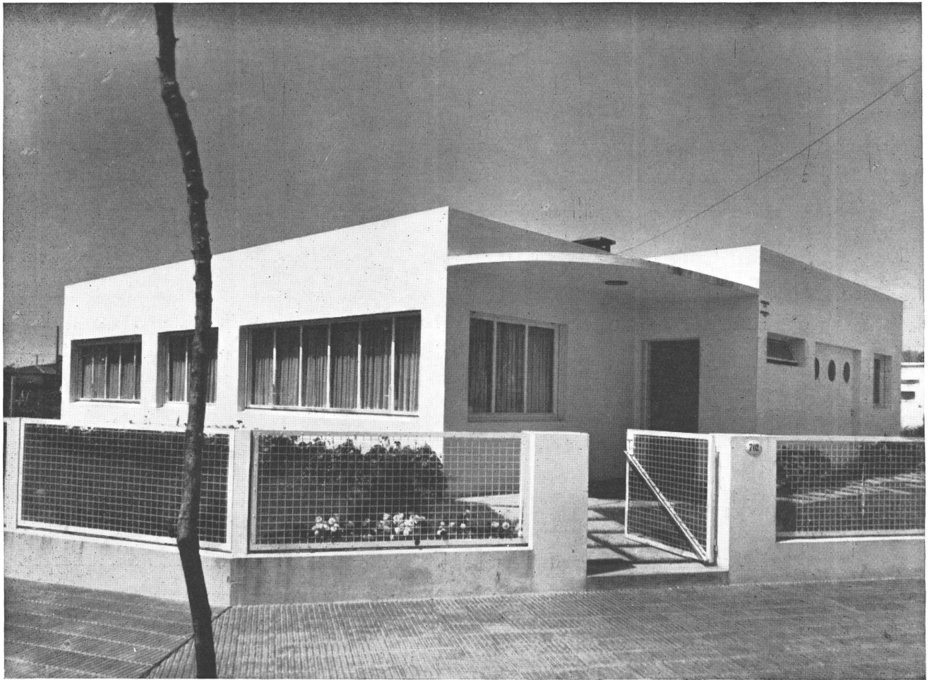
Vista de las fachadas norte y oeste
