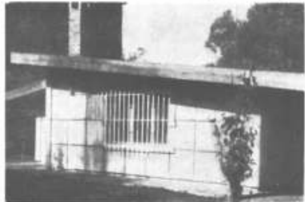
Abajo, izquierda: la foto muestra el detalle del ensamblado de tabiques en una esquina. La foto a la derecha presenta una casa para fin de semana construida con paneles de hormigón.
