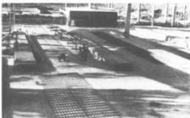
Las láminas de hormigón son prefabricadas en obra.
