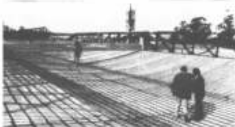
Las láminas montadas y antes de hormigonar.
