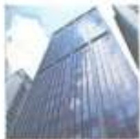
edificio St. Georges, Hong-Kong, cristal "PARSOL" bronce
