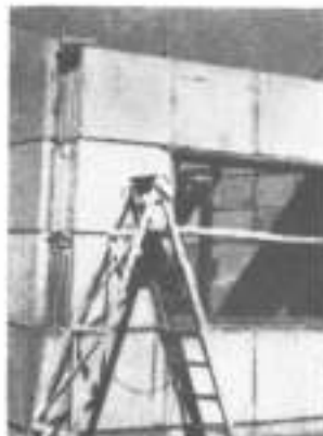
Abajo, izquierda: la foto muestra el detalle del ensamblado de tabiques en una esquina. La foto a la derecha presenta una casa para fin de semana construida con paneles de hormigón.
