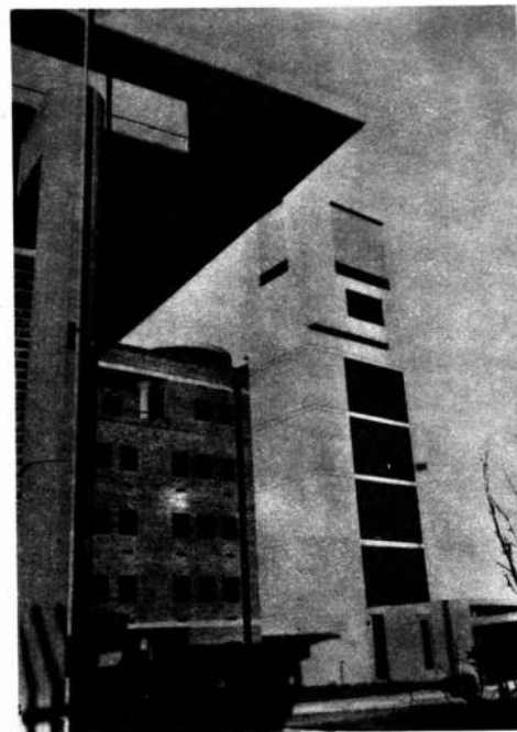
Foto del acceso al edificio técnico administrativo.
