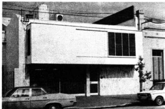
Casa Fiad. Vista del frente.
