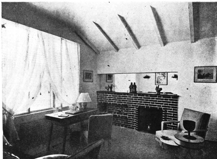
VISTA DEL ESCRITORIO. FRENTE DE LA CHIMENEA EN LADRILLO DE MAQUINA. DEL MISMO LADO, PARTE DEL CIELORRASO CON CABIOS A LA VISTA.
