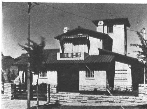
Chalet prop. de la Sra. JOSEFINA R. de WEBER Calle Sarmiento 3640 Director Técnico JUAN G. BUGGIANO SARTORA E HIJOS - CONSTRUCCIONES
