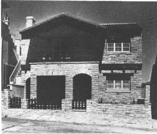
Chalet prop. del Gral. JUAN PIERRESTEGUI Calle Paunero 2520/24 Arq.: SANTIAGO FERRARI DESCOLE SARTORA E HIJOS - CONSTRUCCIONES
