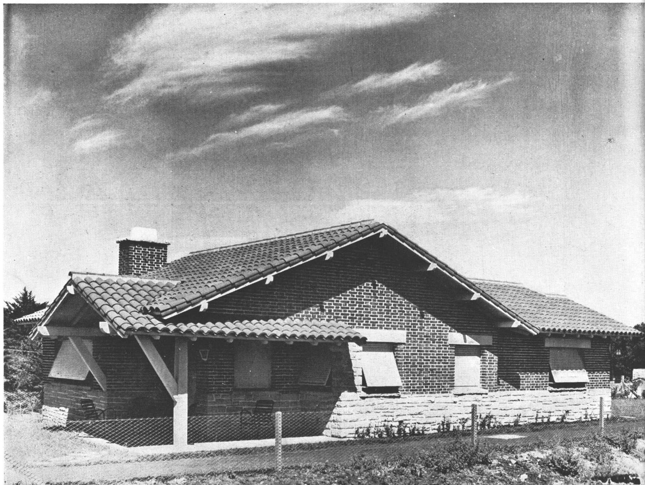
La fachada de la casa, situada en la calle Gral. Urquiza 3339; zócalo de piedra de Mar del Plata, muros de ladrillo a la vista con junta blanca, dinteles y carpintería pintados de blanco, techo de teja española.
