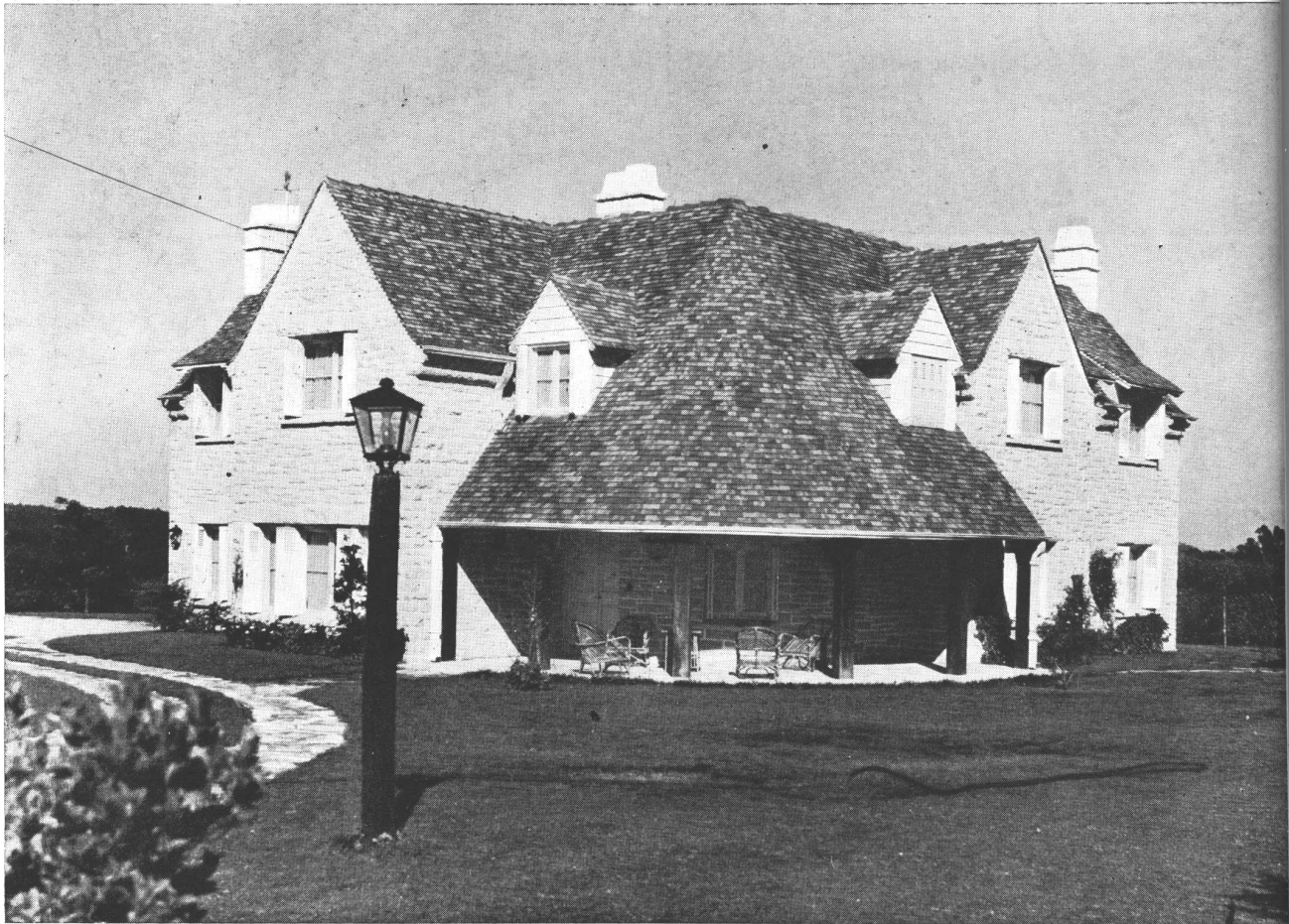
Fachada principal, tomada hacia el ángulo de la galería que protege la entrada. Muros de piedra blanca, techo de tejas tipo "Llao Llao". Lucarnas revestidas de madera dura pintada de blanco.
