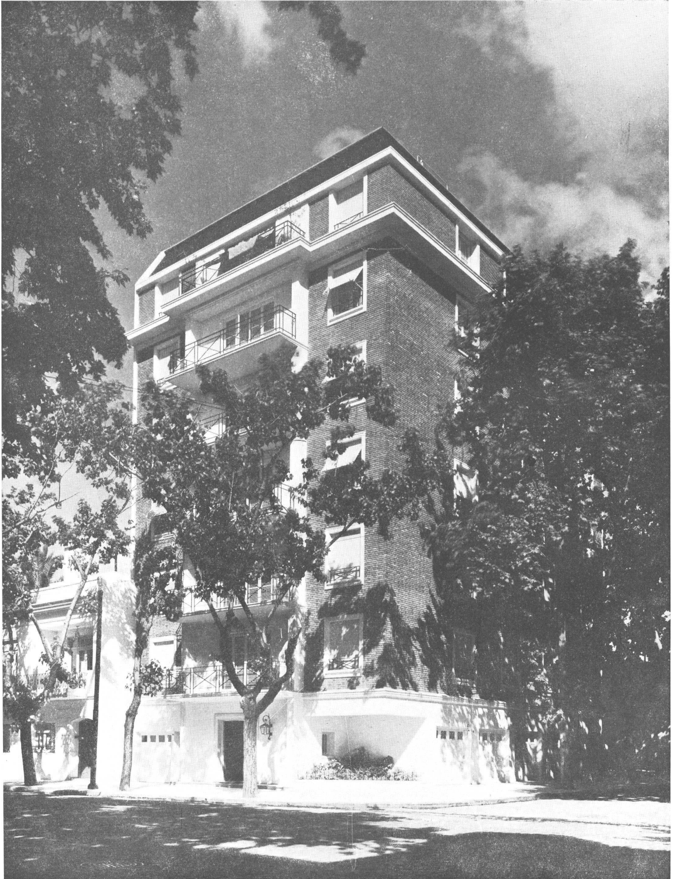
Vista de conjunto de la casa, situada en Pampa y Cuba, donde se aprecia la armonía del edificio con los grandes árboles que lo rodean.
