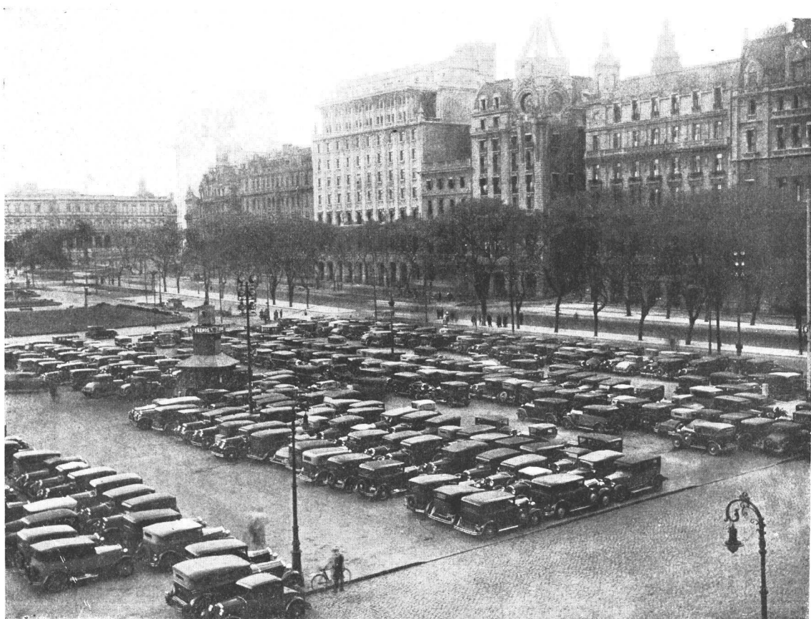
Fig. 19. — Playa de estacionamiento frente al Correo Central
