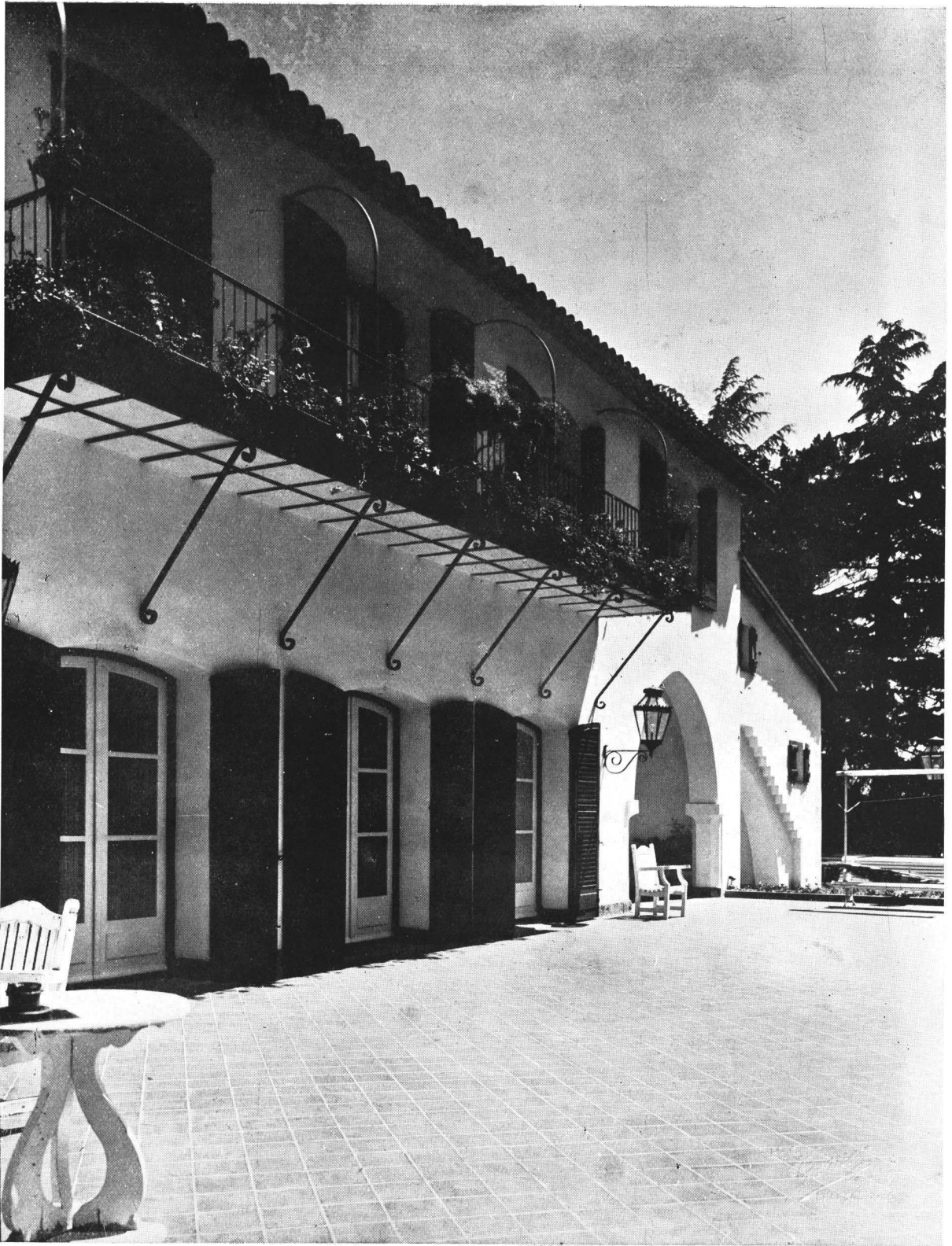
Vista de la terraza hacia el Oeste
