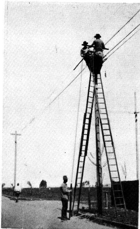
La renovación de cables, crucetas, aisladores, etc. es un trabajo que se efectúa constantemente para mantener las redes de distribución en forma de asegurar un buen servicio.
