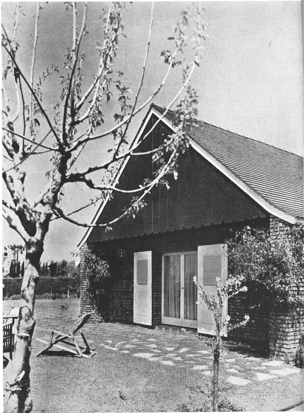
La fachada lateral
