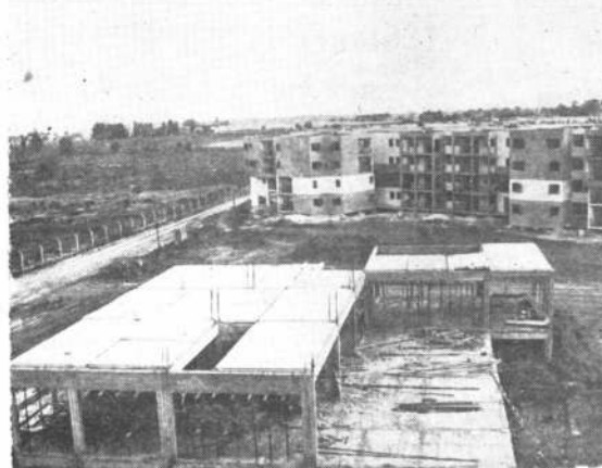
En estas fotos se puede ver una vista aérea del barrio. Etapas constructivas con el uso de elementos prefabricados "in situ". Edificios terminados (el conjunto comprende 128 edificios de planta baja y tres pisos) y puentes peatonales ya terminados.
