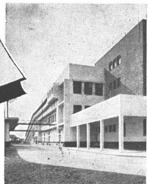
Vista del costado exterior de la rampa en el pabellón industrial. Un amplio y sólido pavimento de hormigón circunda todo el edificio.
