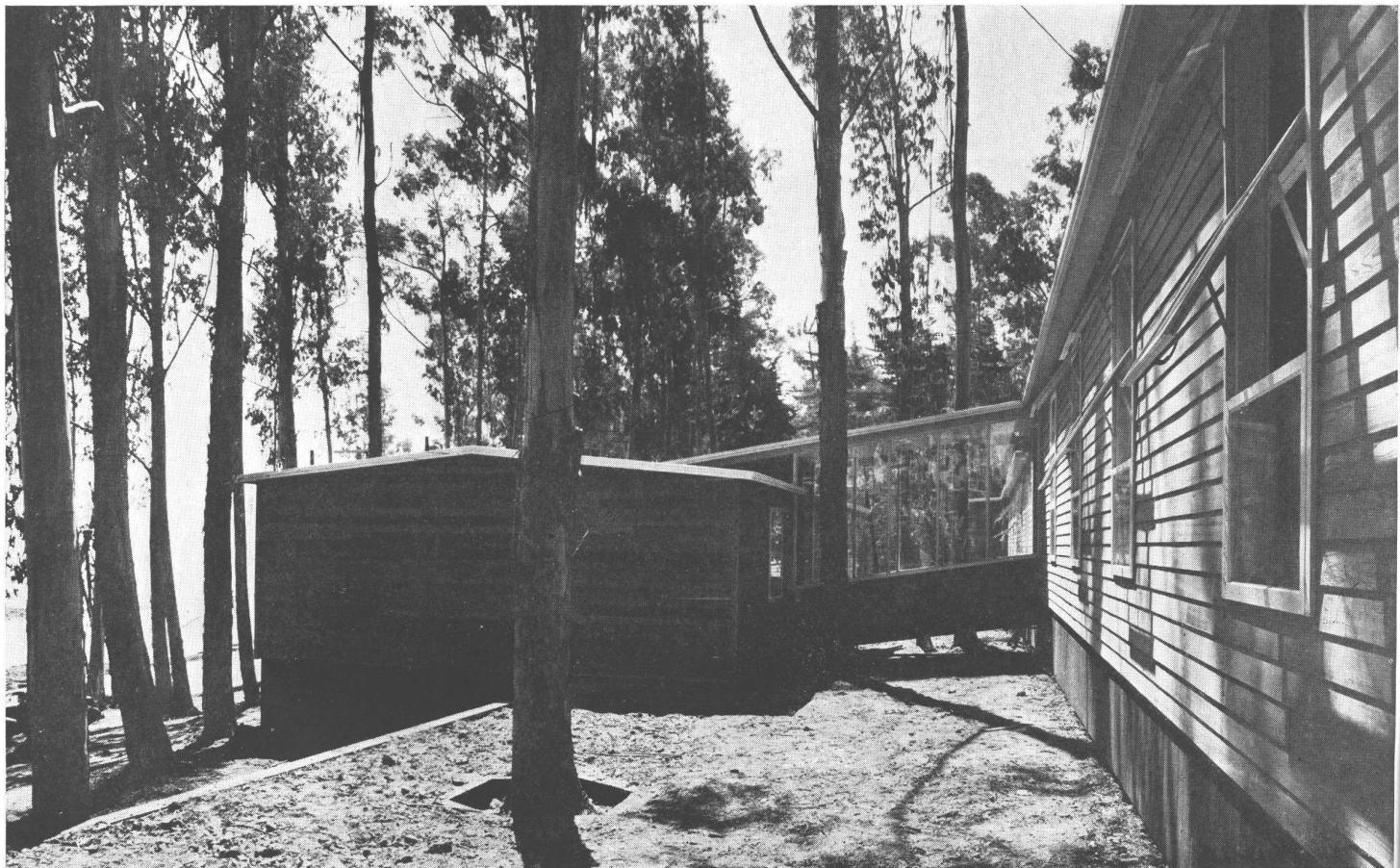
La diferencia de nivel entre el cuartel y la unidad separada de lavatorios ha sido solucionada por una rampa cerrada por vidrios.
