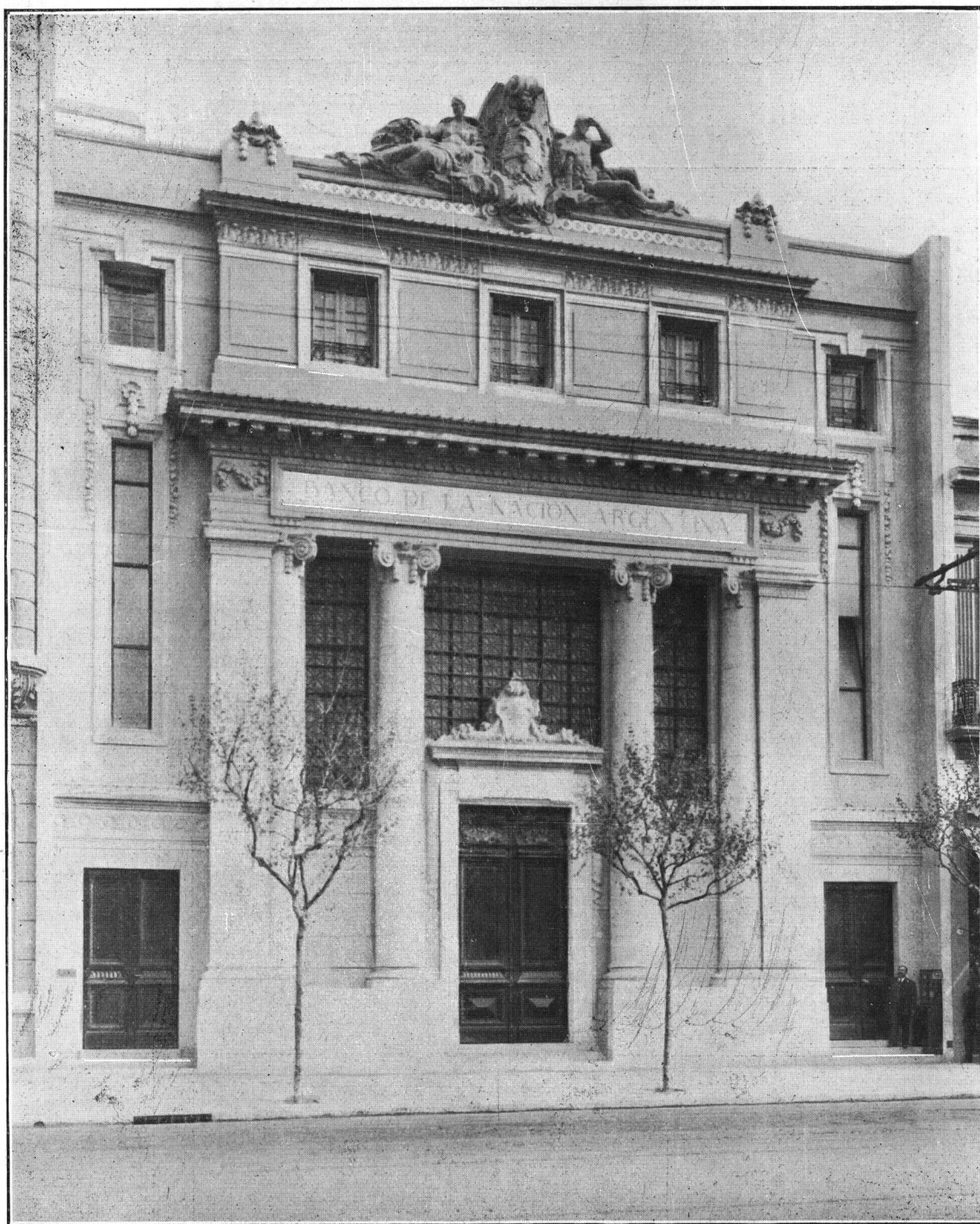
Fachada del Edificio de la Agencia N° 5 del Banco de la Nación Argentina, obra del Arquitecto Alejandro Christophersen.
