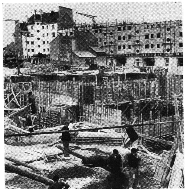
Edificios construídos en parte con elementos prefabricados en la ciudad de Orleáns, donde se levanta un barrio experimental (foto a la derecha, página siguiente).
