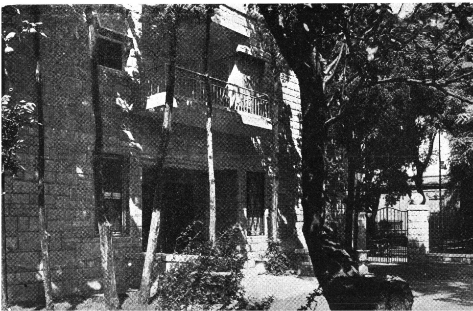
Segunda entrada principal sobre la Avenida Las Heras
