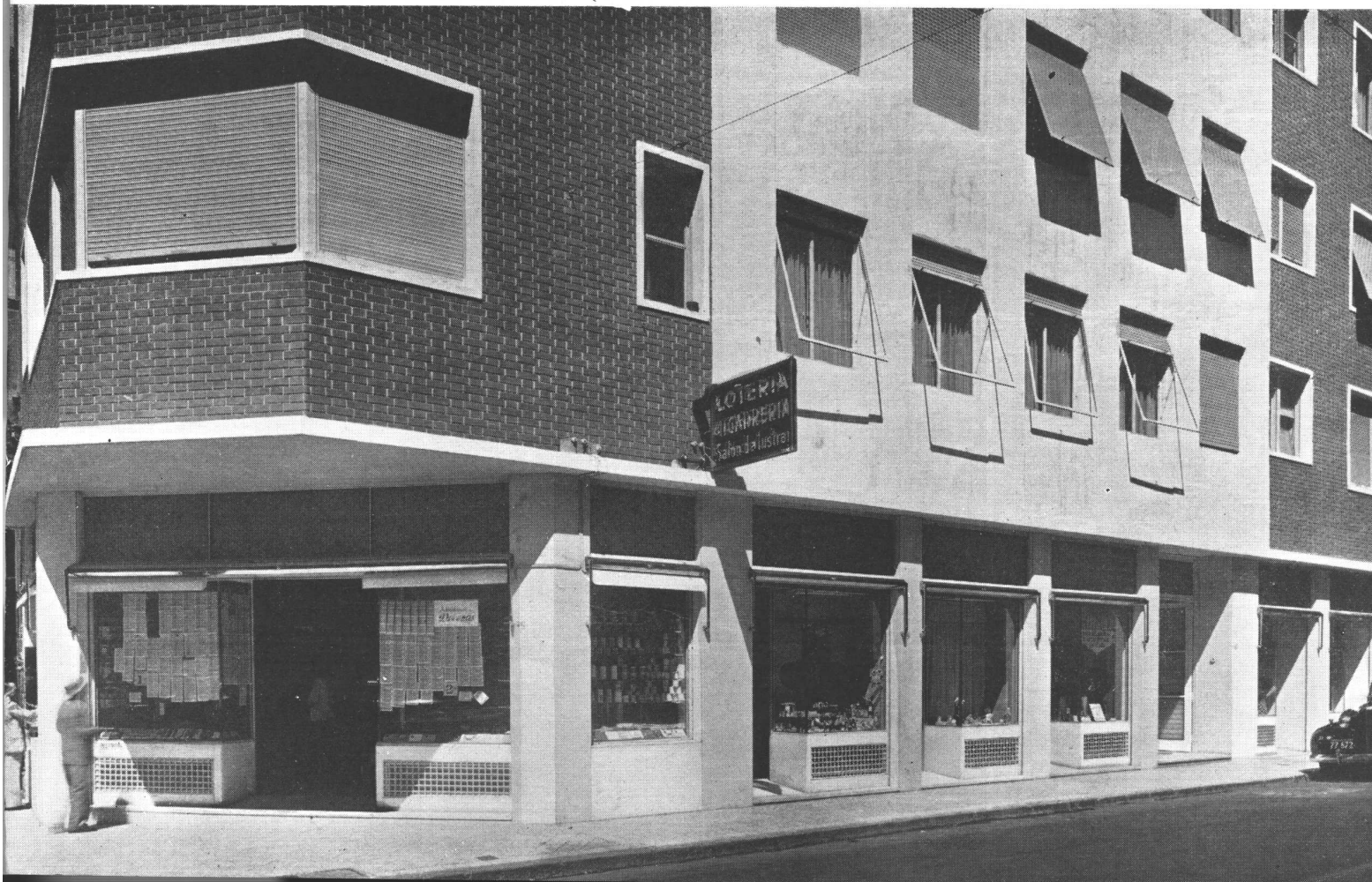
Un detalle de la fachada
