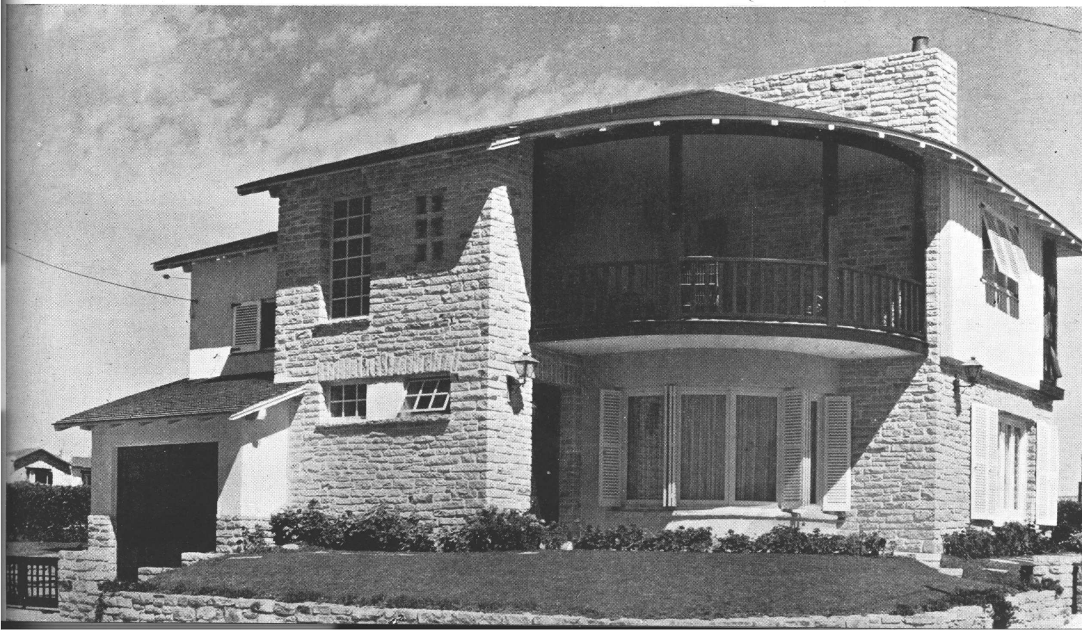
Vista de la vivienda con muros de piedra de la región, carpintería de madera y techo de teja de cerámica
