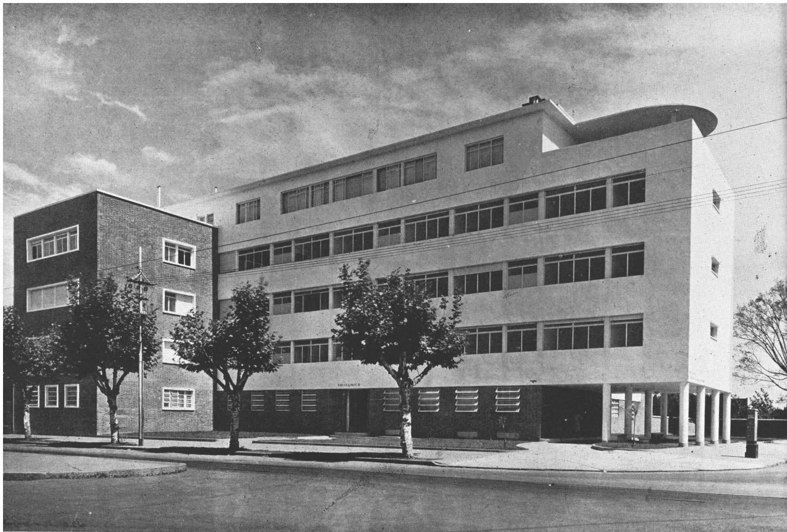
Vista exterior; hacia la derecha, el pórtico de entrada
