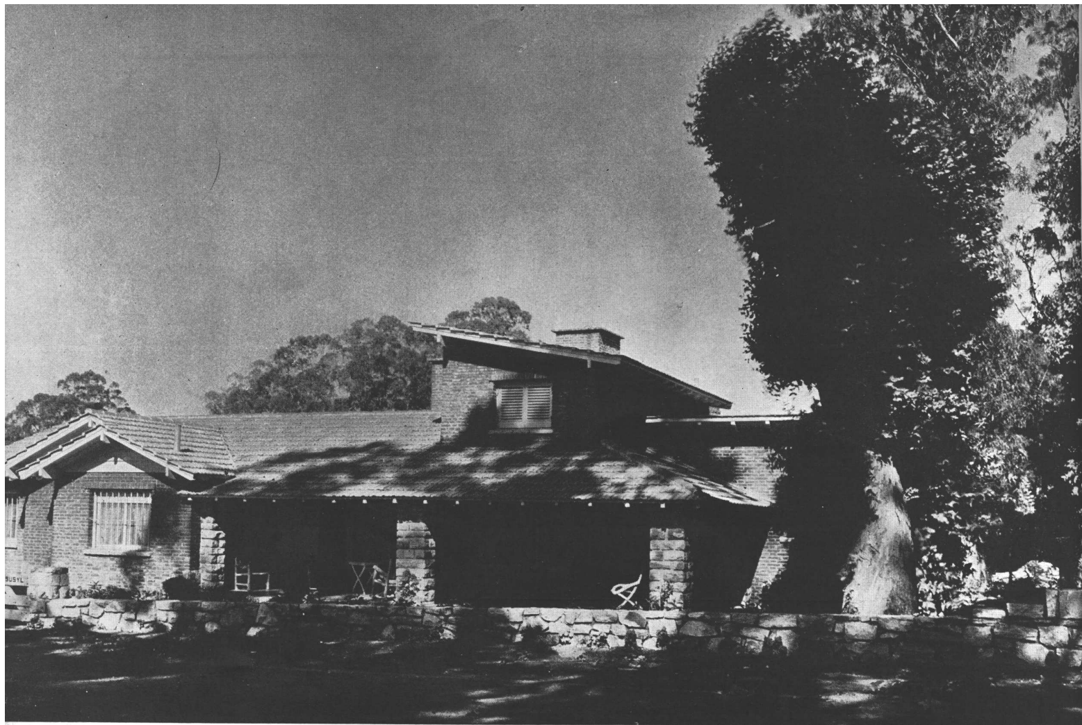
Vista del frente principal
