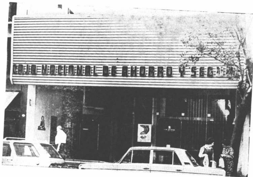
Entrada de acceso a la agencia. Aspecto general de la planta baja. Desde la planta baja se observa la escalera que conduce a la bandeja de entrepiso.
