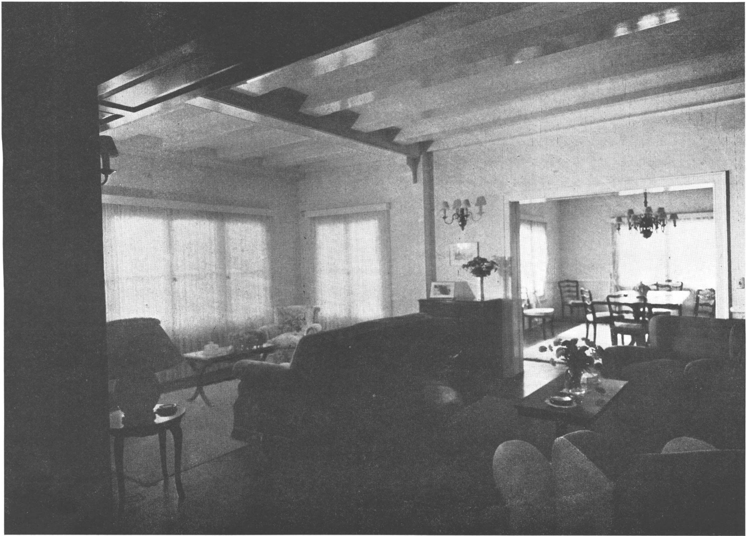
ARRIBA, el living room con el comedor al fondo. Piso de caldén de 1" x 6". Envigado de cedro pintado de blanco al esmalte. Carpintería en general, de cedro pintado de blanco al esmalte. ABAJO, los dormitorios de niñas y niños, amueblados con muebles de maderas claras y tapicerías adecuadas al carácter de los ambientes.
