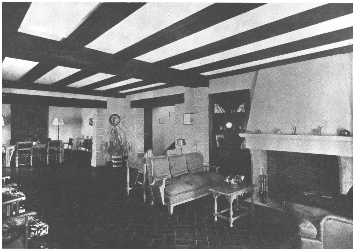
Living room, con el comedor al fondo. Piso de material cerámico de 0.14 por 0.28. Envigado del cielo raso en cedro teñido y encerado. Paredes al agua color crema. Chimenea de piedra de Mar del Plata trabajada a la punta gruesa.
