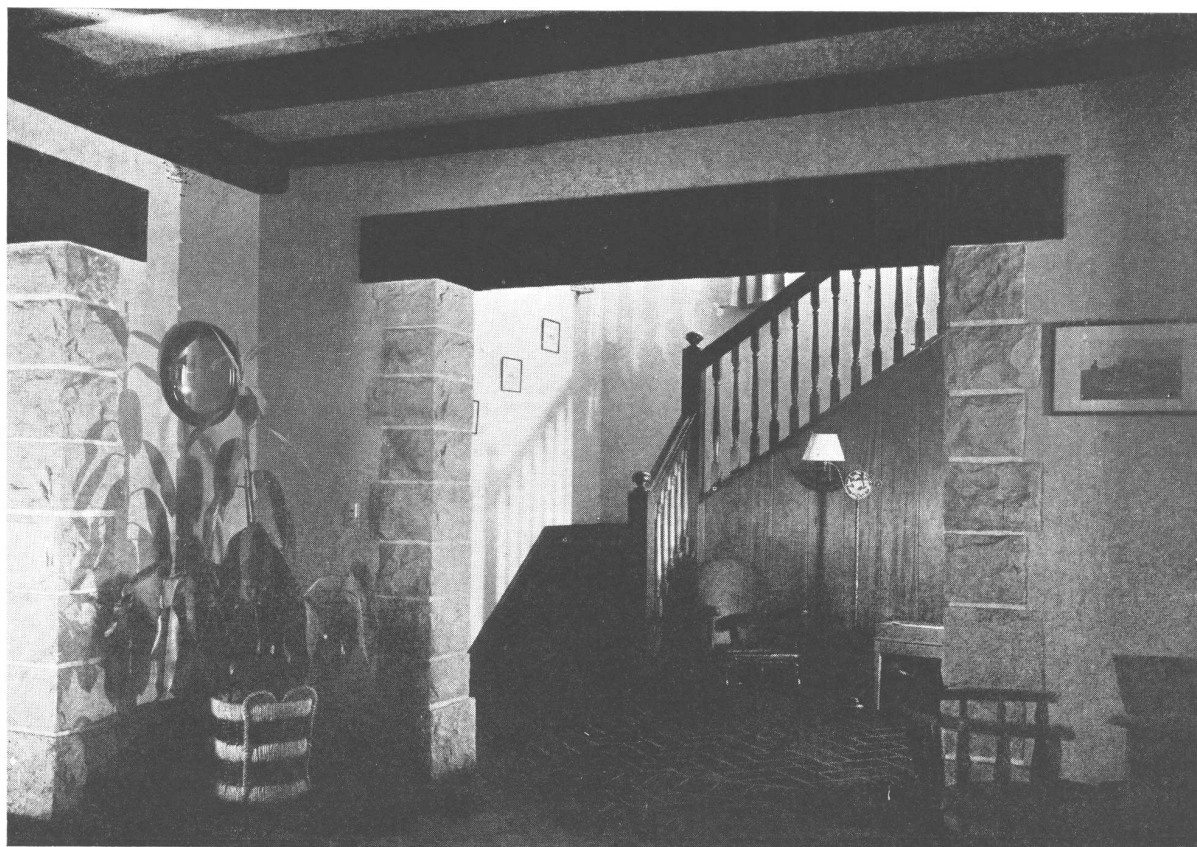
Vista del hall de la Planta Baja y escalera principal, desde el living room. Escalera y carpintería en cedro, teñido y encerado. Piso de baldosas de cerámica "Super Alberdi" de 0.14 x 0.28. Paredes al agua color crema.
