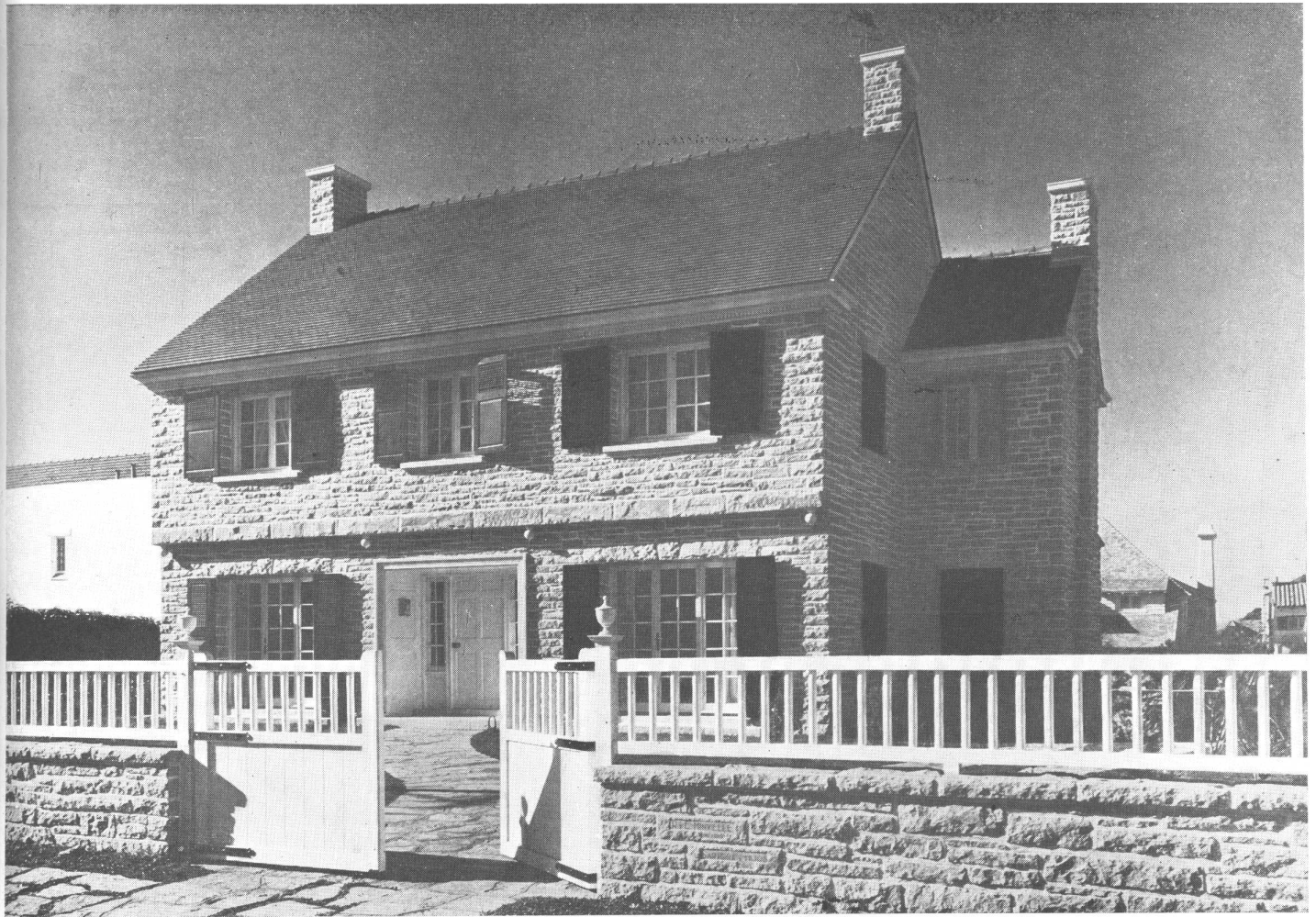
Frente principal de la vivienda, situada en Castelli 245. Revestimiento en piedra Mar del Plata. Techo de tejas "Llao Llao" tipo pizarra. Portones y cerca en incienso pintado de blanco. Carpintería de cedro pintada del mismo color. Persianas en verde.
