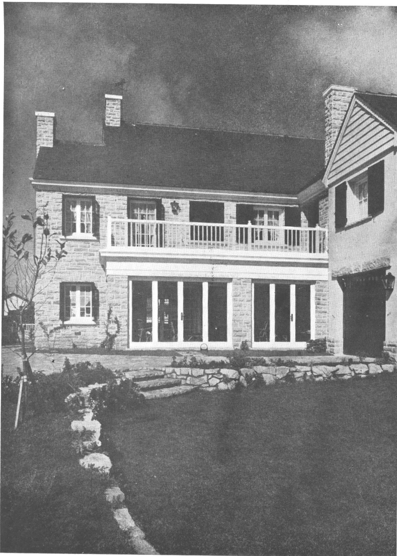
Frente posterior. Balcón de incienso pintado de blanco. A la derecha, garage y dependencias de servicio. Paredes exteriores revocadas, dinteles y zócalos de piedra Mar del Plata. Mojinete revestido en madera dura pintado de blanco.
