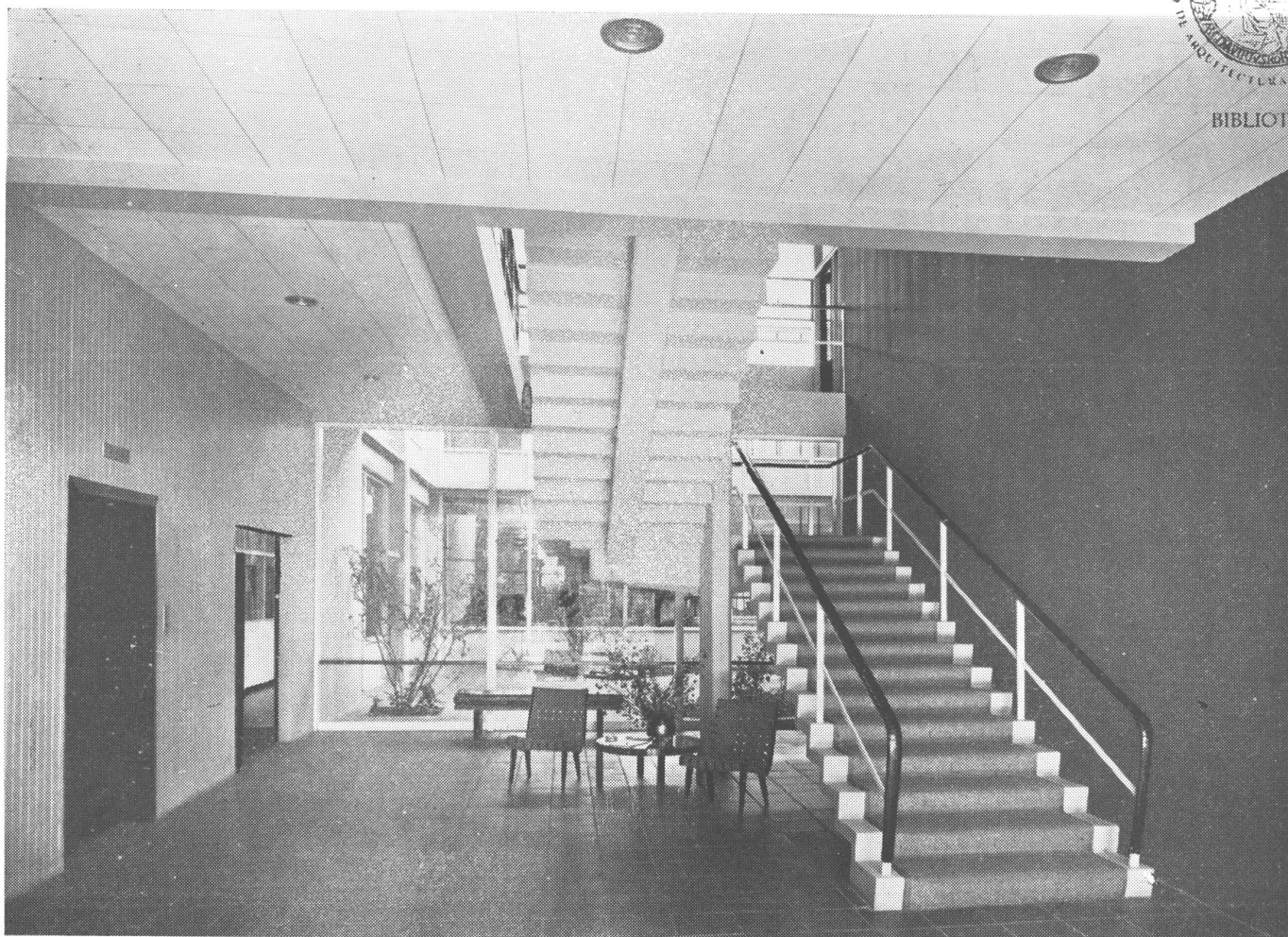
Vista hacia el patio interior desde el vestíbulo de entrada.
