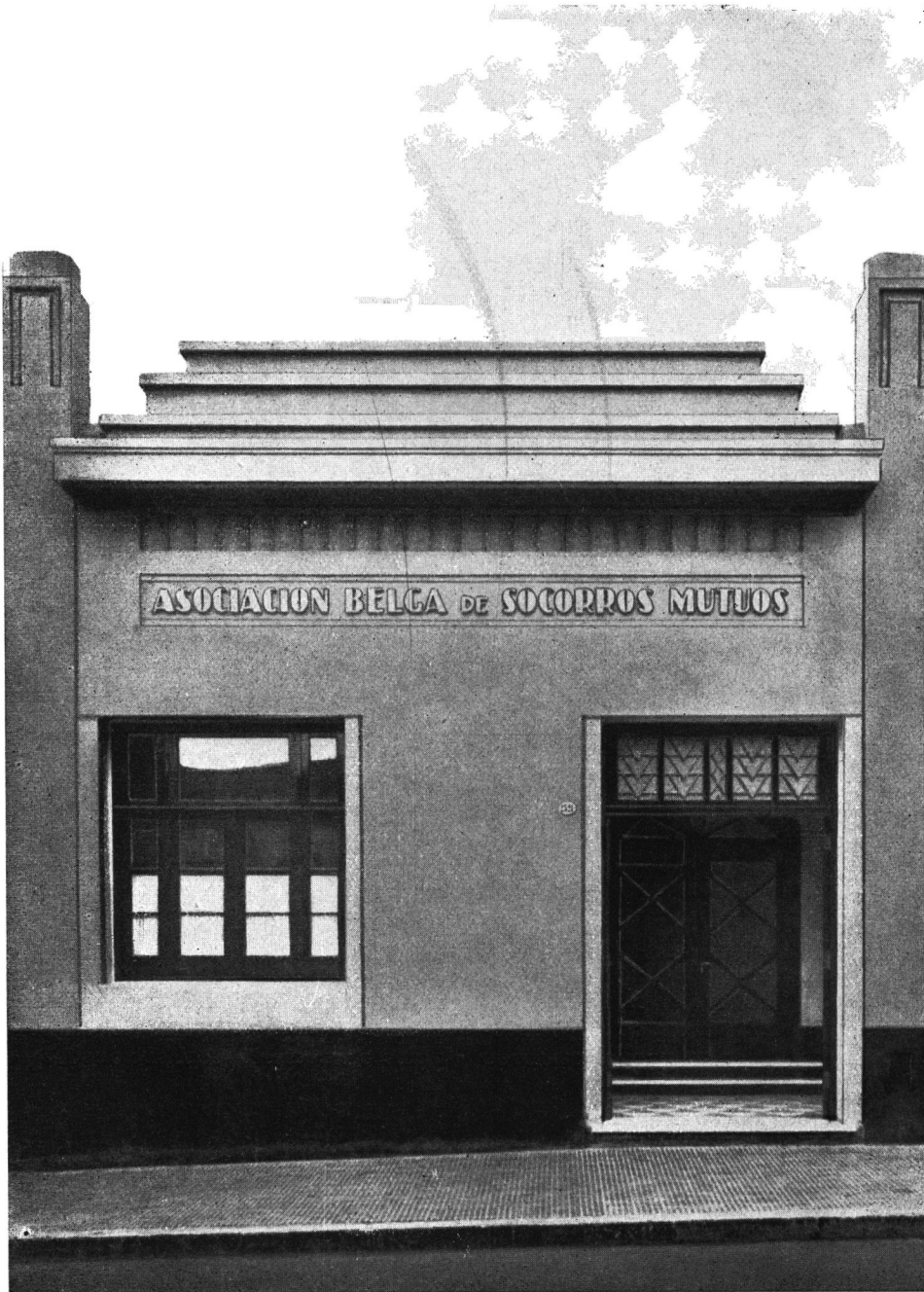
EDIFICIO DE LA ASOCIACION BELGA DE S. M. — VICTORIA 2531
