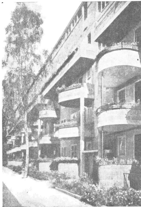
FIG. 6. — Casas económicas obreras construídas en Berlín.
