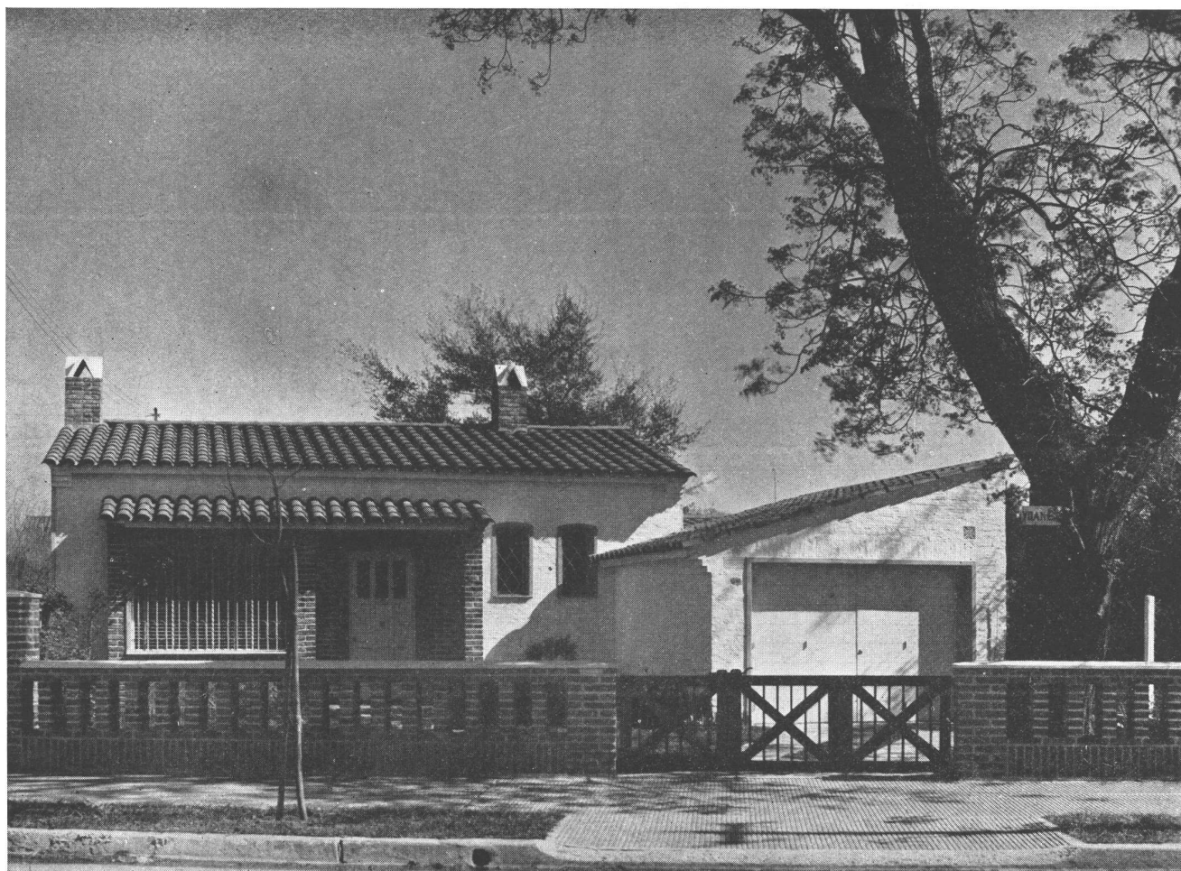
La fachada de la casa, situada en la calle Almafuerde 1042.
