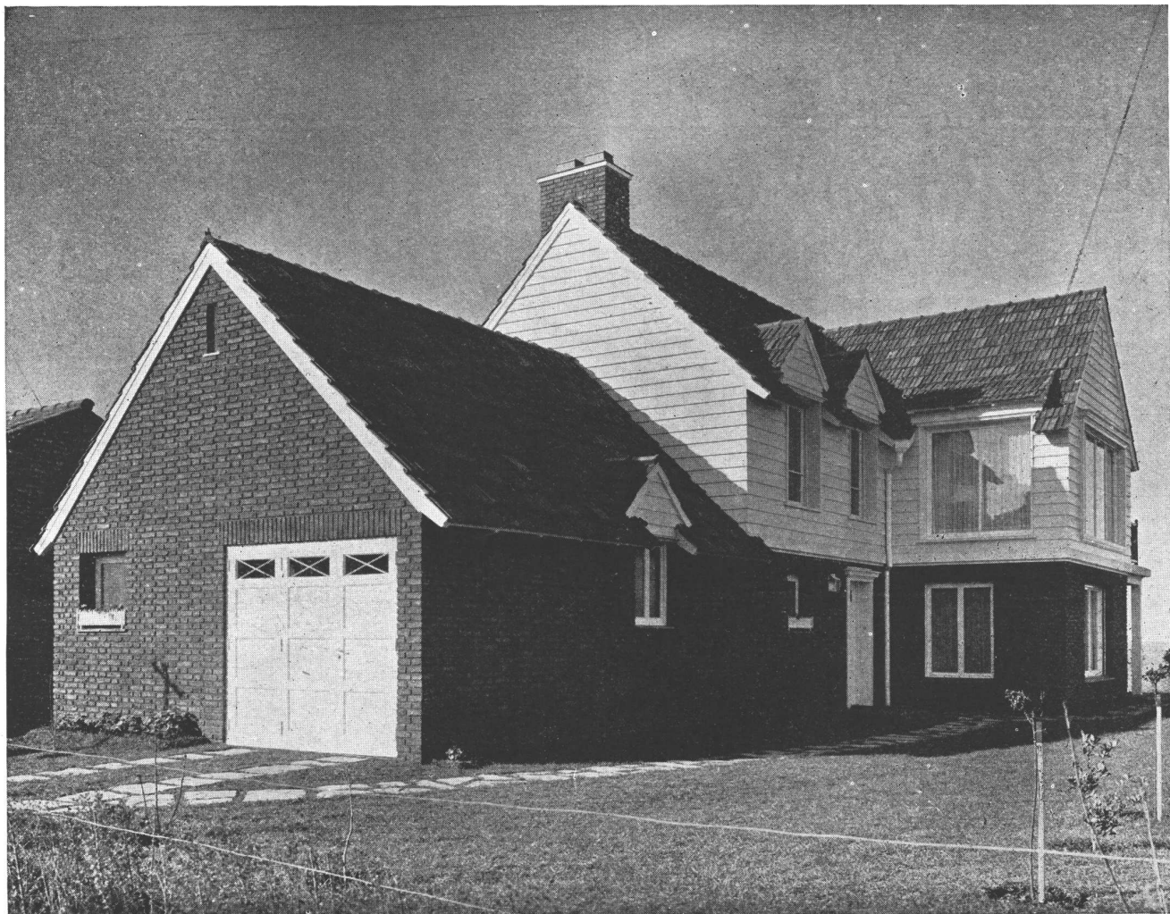
Vista de conjunto desde la calle; la casa está situada en Andrés Ferreyra 3455 y pertenece a la Sra. Del'a Bonorino de Claypole
