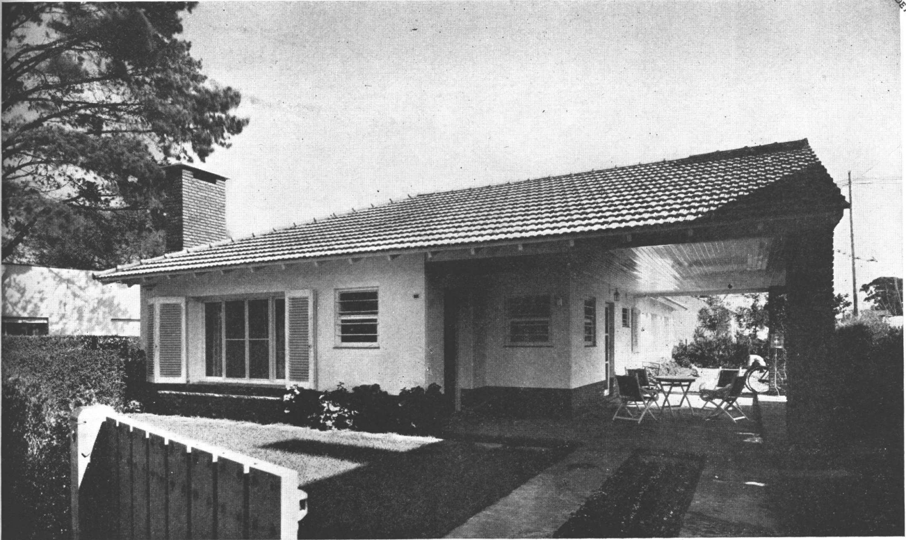
Fachada de la casa sobre la calle
