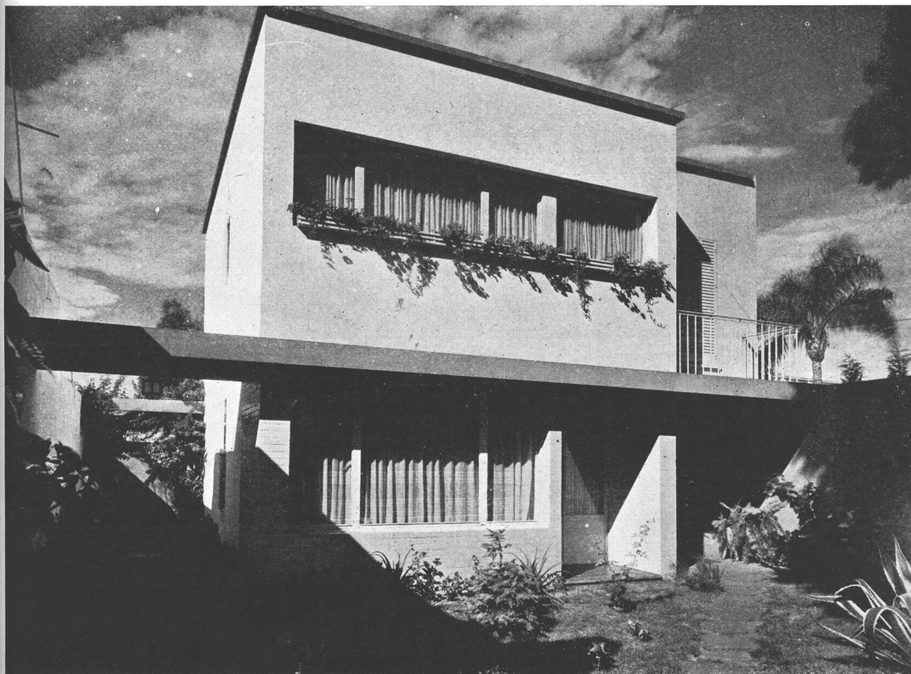
La fachada de la casa, situada en la Avenida del Tejar 2687
