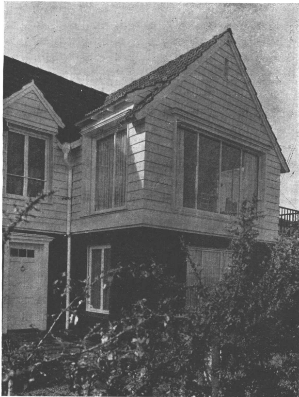
Vista parcial de la casa; puerta principal de entrada y ventanales del living room en planta alta, con acceso a la terraza.
