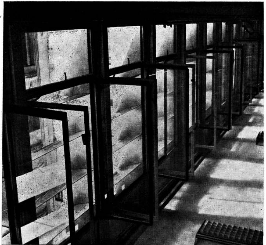
Desde el interior de las oficinas hacia la calle. Se aprecia la división modular de la carpintería metálica y las pantallas de aluminio móviles a través de los cristales.
