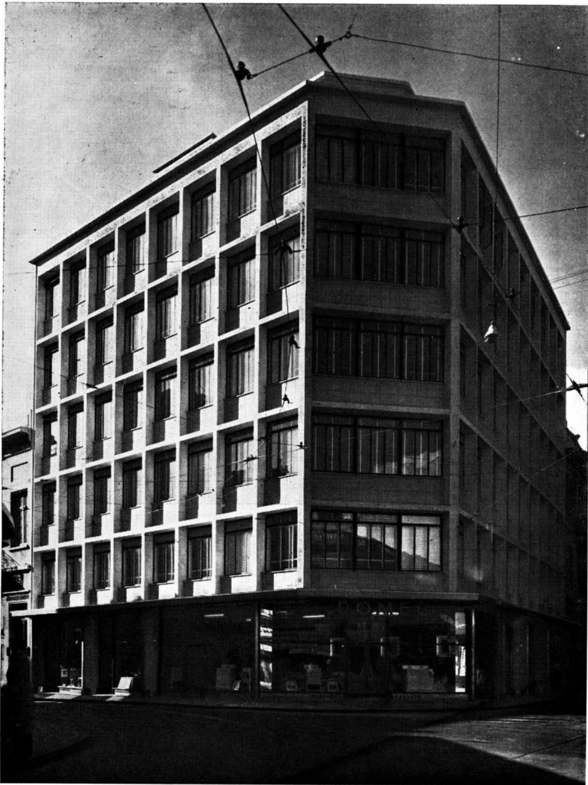
El frente del edificio situado en Viamonte y Esmeralda.
