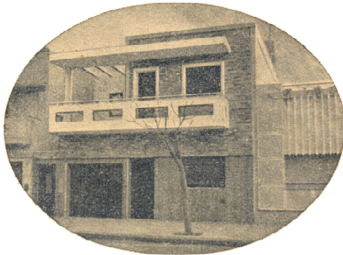
Boulevard Zavaleta 2959/63. - Propietario: señor Cayetano Marino. - Construcción: Empresa "Veromar".
