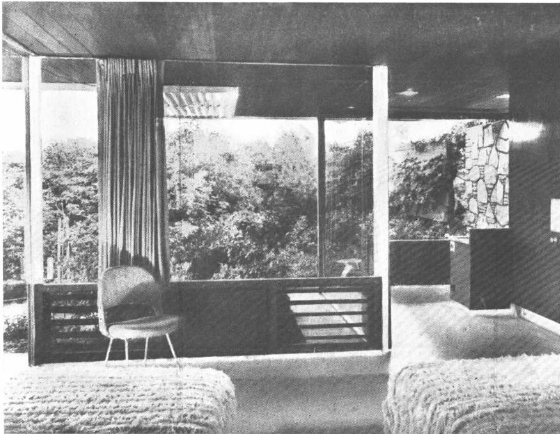
Otro aspecto del dormitorio principal en que se observa la ventilación que proviene del zócalo de la ventana.
