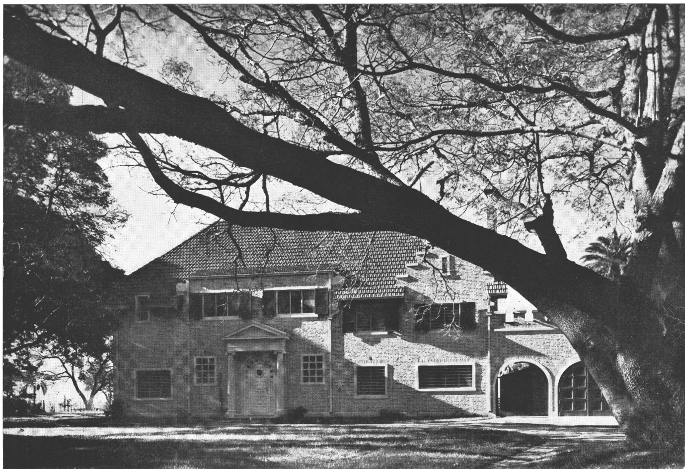
Vista de la fachada principal
