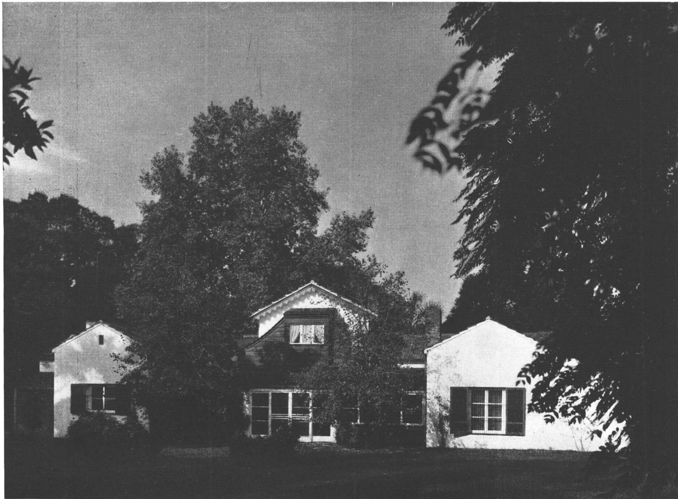
Una vista de conjunto de la fachada posterior (Norte)
