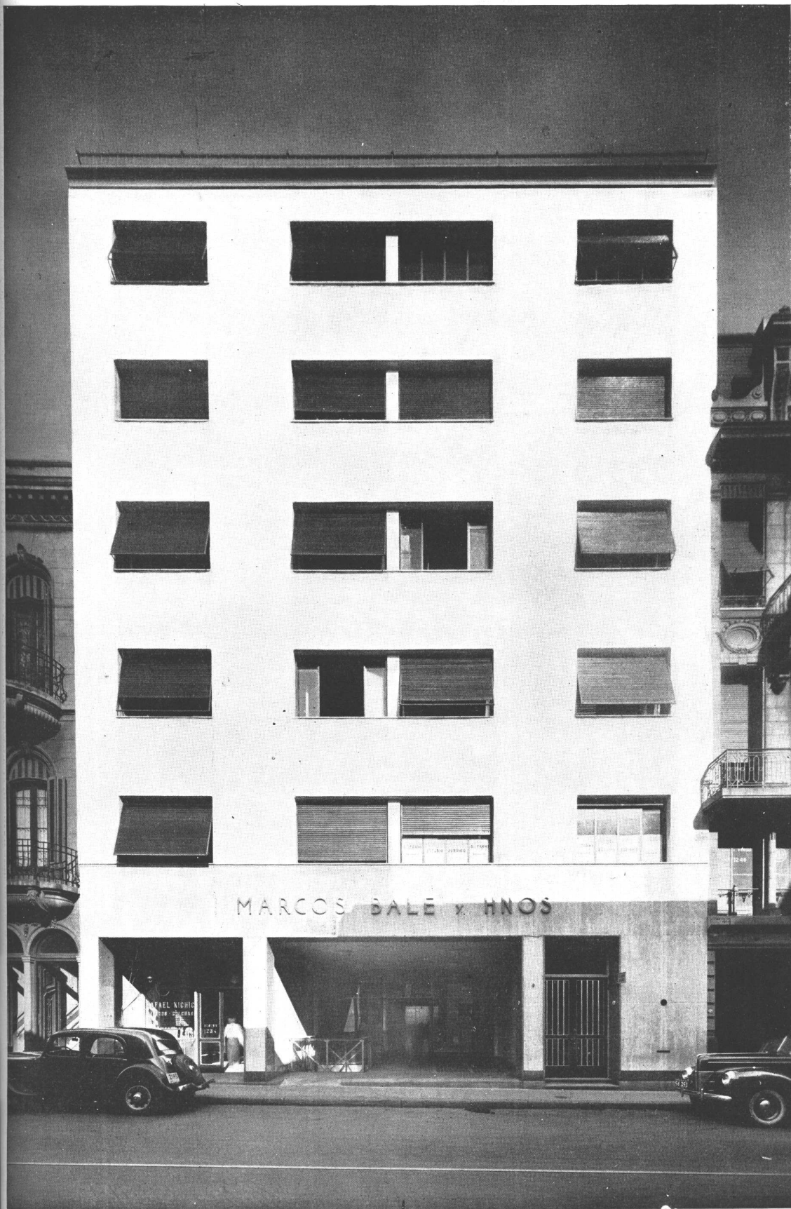
Vista de la fachada, de revoque verde salpicado, revestimiento de travertino; moquetas y zócalos de granito rosado de San Luis, escalones y umbrales de piedra gris de Córdoba; puerta de entrada a las oficinas, de hierro con barrotes y contravidrios de aluminio.
