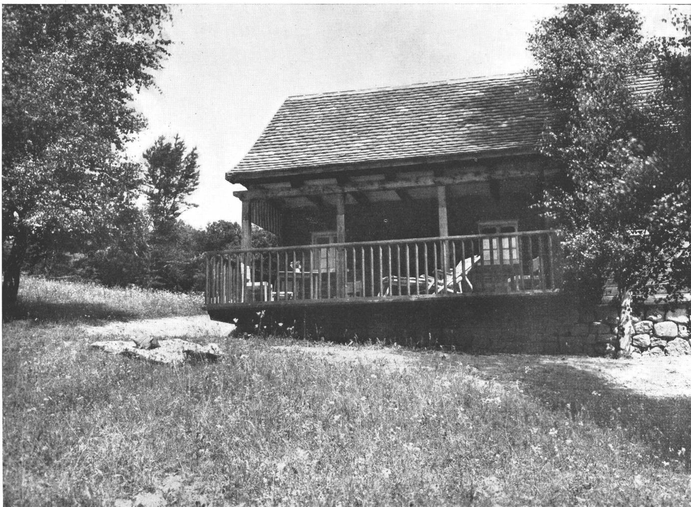
Foto 4. - La galería de amplias dimensiones, es un recinto ideal para pasar las horas de sol. Se comunica con el living por una doble pueria y dos ventanas
