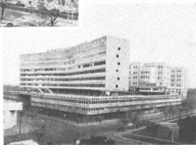
Edificio Secretaría de Aeronáutica. Av. Maipú 2, Puerto Nuevo Buenos Aires
