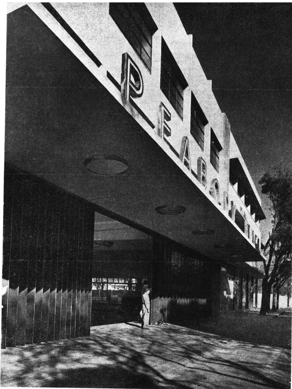
Entrada principal: puerta metálica de 21 metros de ancho accionada eléctricamente
