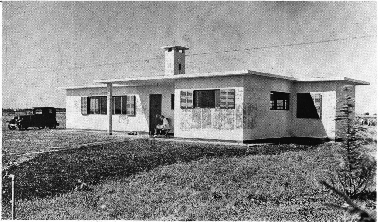
VISTA DEL NORTE
