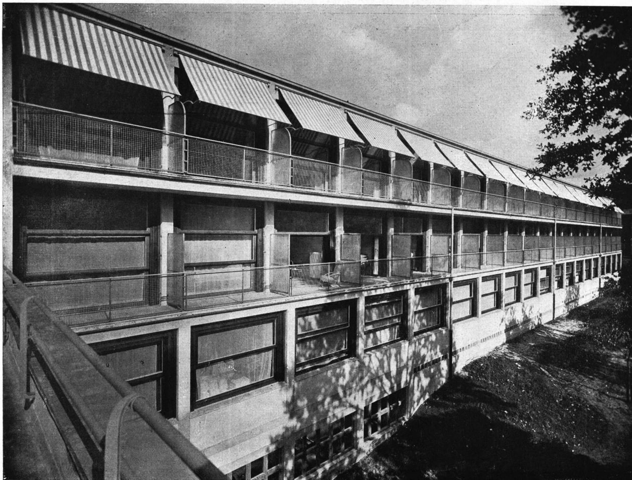
Frente Sur con piezas de enfermos, "loggias" y balcones
