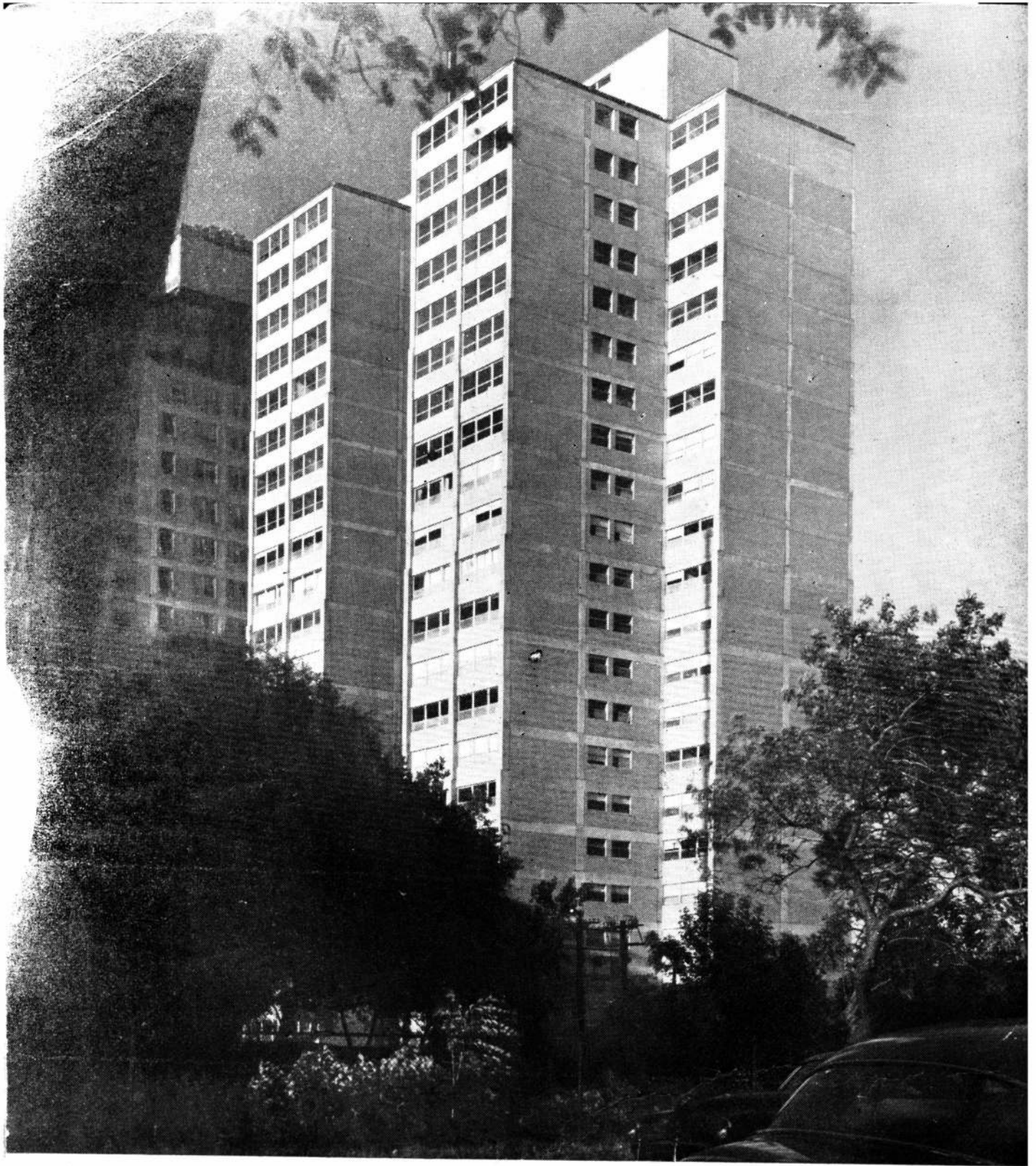
Vista de las fachadas posterior y lateral.
