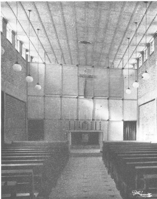
Mirando a lo largo de la nave hacia el santuario, se aprecia el carácter de todo el proyecto. Paredes de ladrillo, piso de hormigón, cielo raso de fibras prensadas acústicas, pared del santuario de pino de Oregón son mostradas francamente. El altar es una mesa, expresando su real significado.
