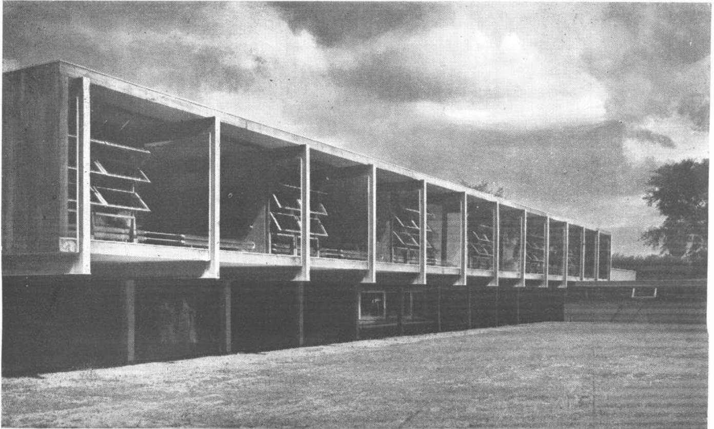
El ala elevada de aulas diseñada y construida con algo de la fineza del constructor de violines. Por ejemplo, las armaduras de acero rígidas, consisten en formas standard estructurales, unidas a inglete y soldadas en las esquinas. Para obtener una perfecta continuidad de línea, el soldado debía ser una operación bien precisa. Aunque de antemano se pensaba que era difícil conseguir un terminado perfecto de los equipos de soldadores, el resultado deseado se llegó a obtener sin excesiva dificultad.
