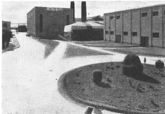
En el interior de la planta del Frigorífico Smithfield, se construyeron playas y caminos de hormigón, totalizando más de 4.500 m<sup>2</sup>. Para librarlo de inmediato al tránsito de los vehículos de carga, el pavimento fué construido con cemento 'INCOR'.
