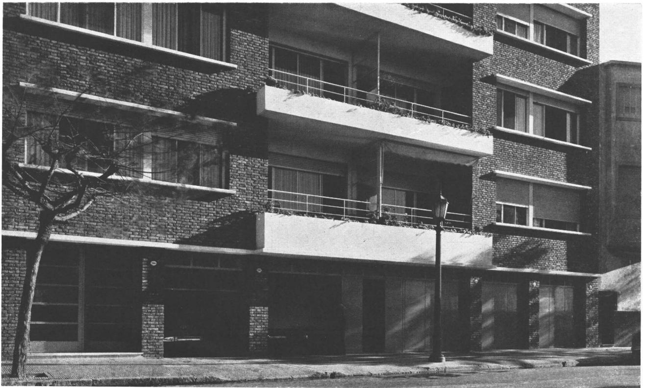
Detalle de la fachada, donde se aprecian las 5 portadas levadizas "Bovel" de acceso al garage y la entrada de servicio en el centro. La solución de guardapolvos y antepechos de hormigón armado revocado en las ventanas es simple y lógica, dando a la vez fuerza a los dos cuerpos laterales de ladrillo a la vista.
