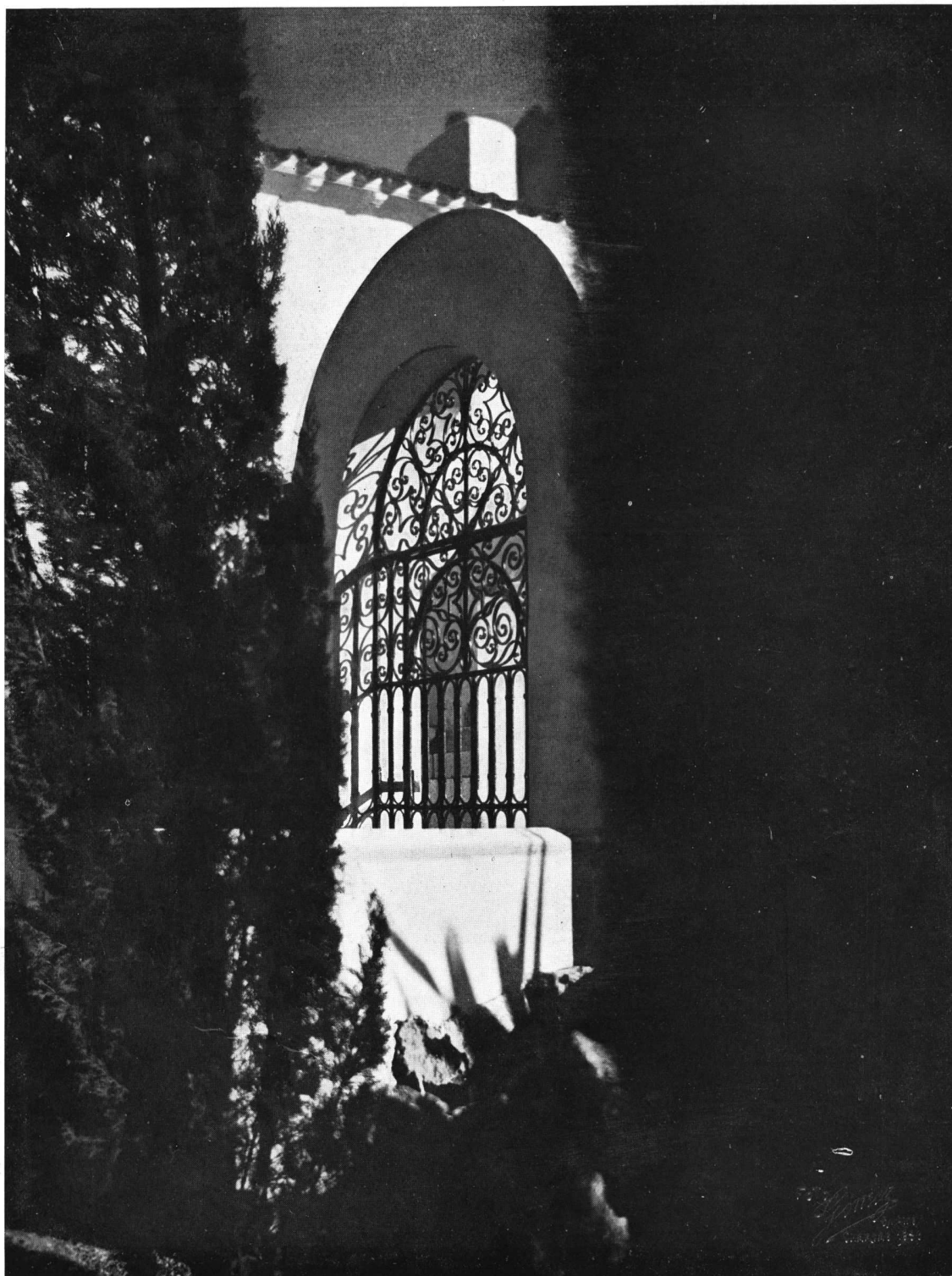
Casa de campo en Tandil Propiedad de la Señora Leonor U. de Anchorena DETALLE DEL FRENTE Arq. ALEJANDRO BUSTILLO
