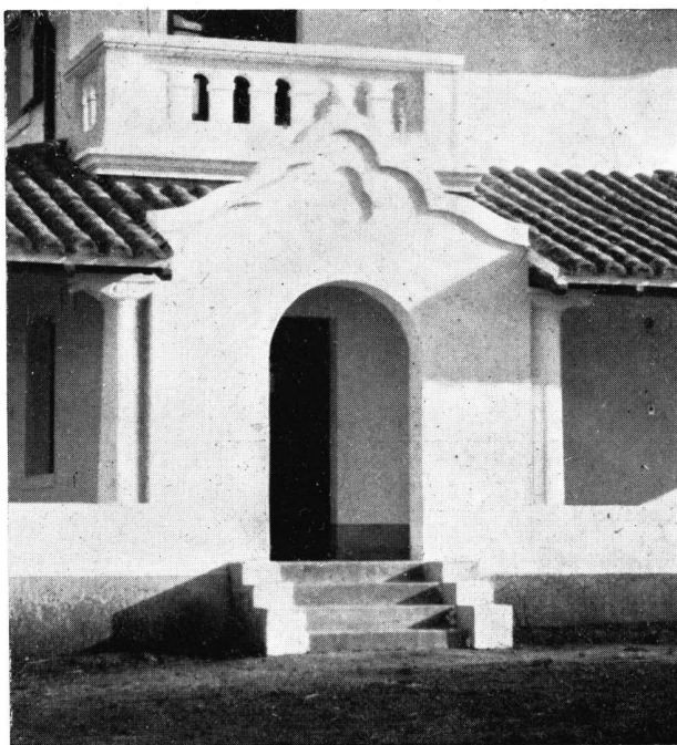
Un pórtico sencillo en el estilo español que da un carácter de acogedora hospitalidad a esta casa de estancia.
