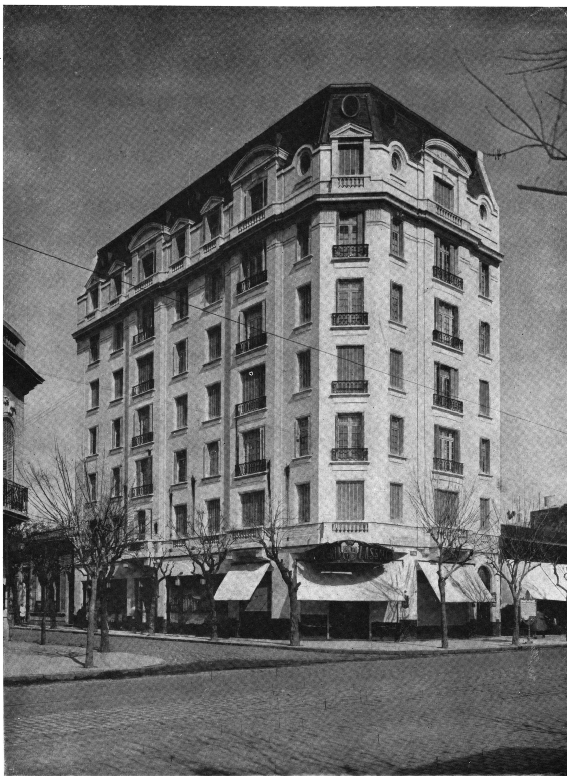
Casa de renta Rivadavia y Membrillar Propiedad de la sucesión Dacharry FACHADA Aberastain Oro y Dudley, Arqs.
