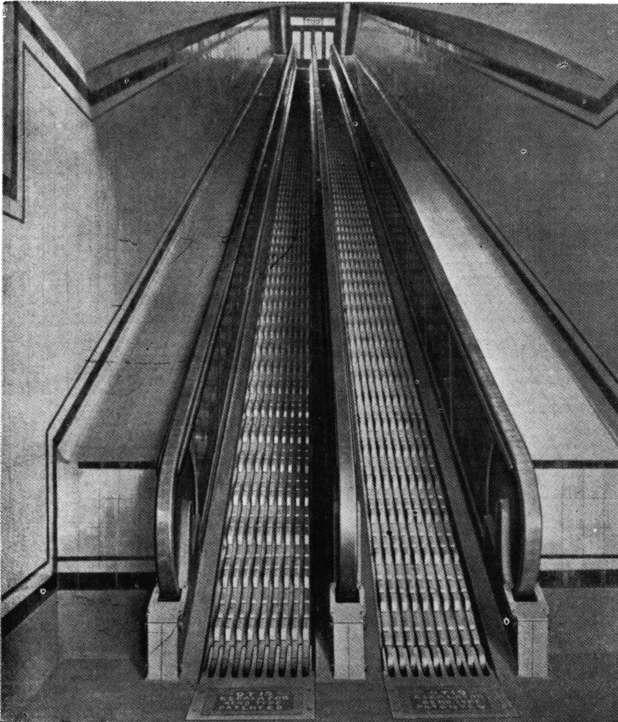
Doble "Escalator" instalado en la estación Park Street del subterráneo de Boston (E. U. de América)
