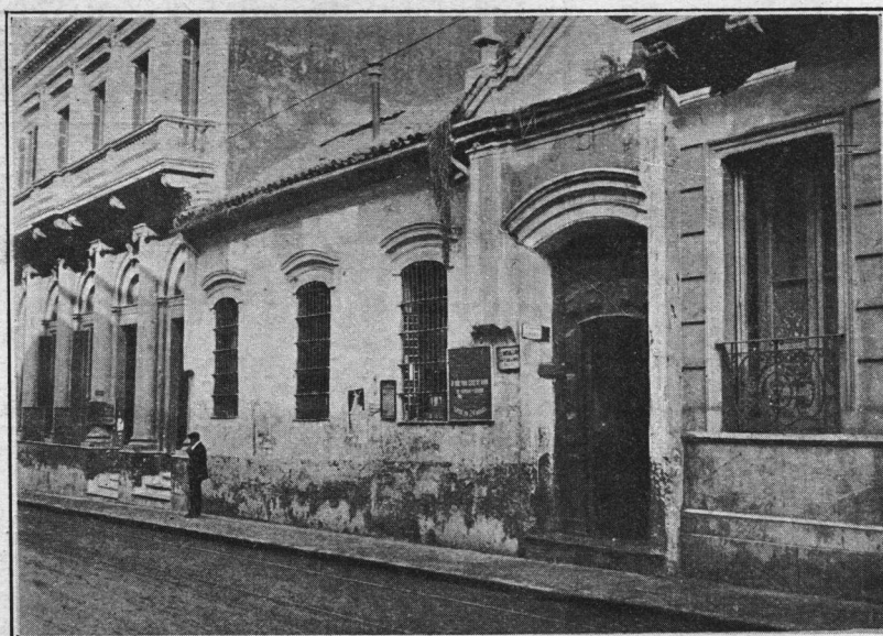
FIGURA 22. — Fachada colonial de la planta fig. 21. — Perfilado rudimentario.
