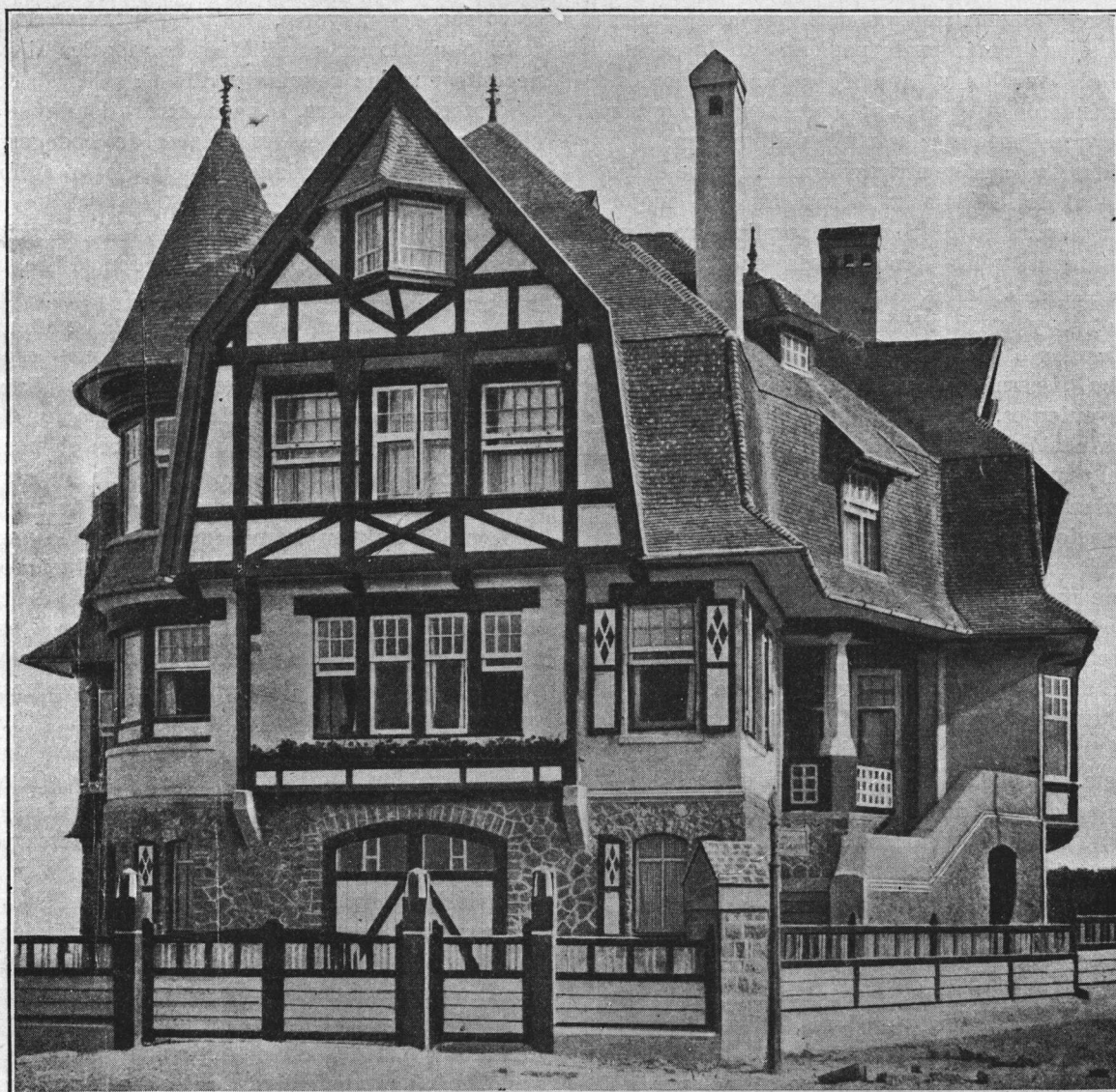
FIGURA 25. — Infuencia del clima y de los materia'es en la composición. — Villa del arquitecto Cordonnier. — Entramado normando de madera. — Piso bajo de piedra bruta en aparejo po:igonal. — Observaciones como en la fig. 23 en lo que a protección contra las intemperies se refiere.
