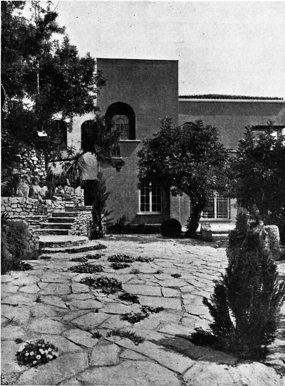
Fachada al Poniente
