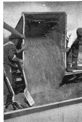
VIERNES HORMIGONANDO CON 'INCOR'
