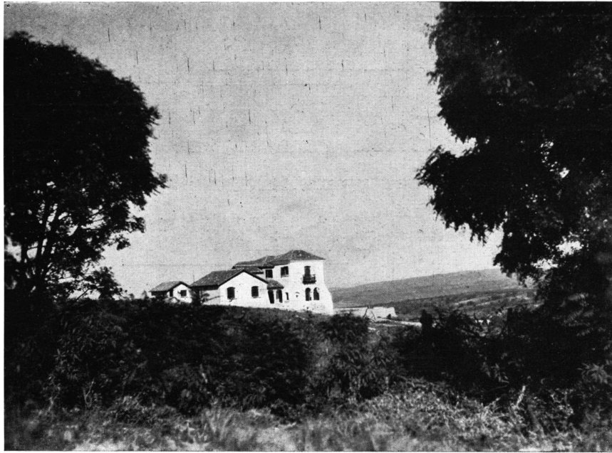
Casa del Sr. B. Podestá en Valle Hermoso
