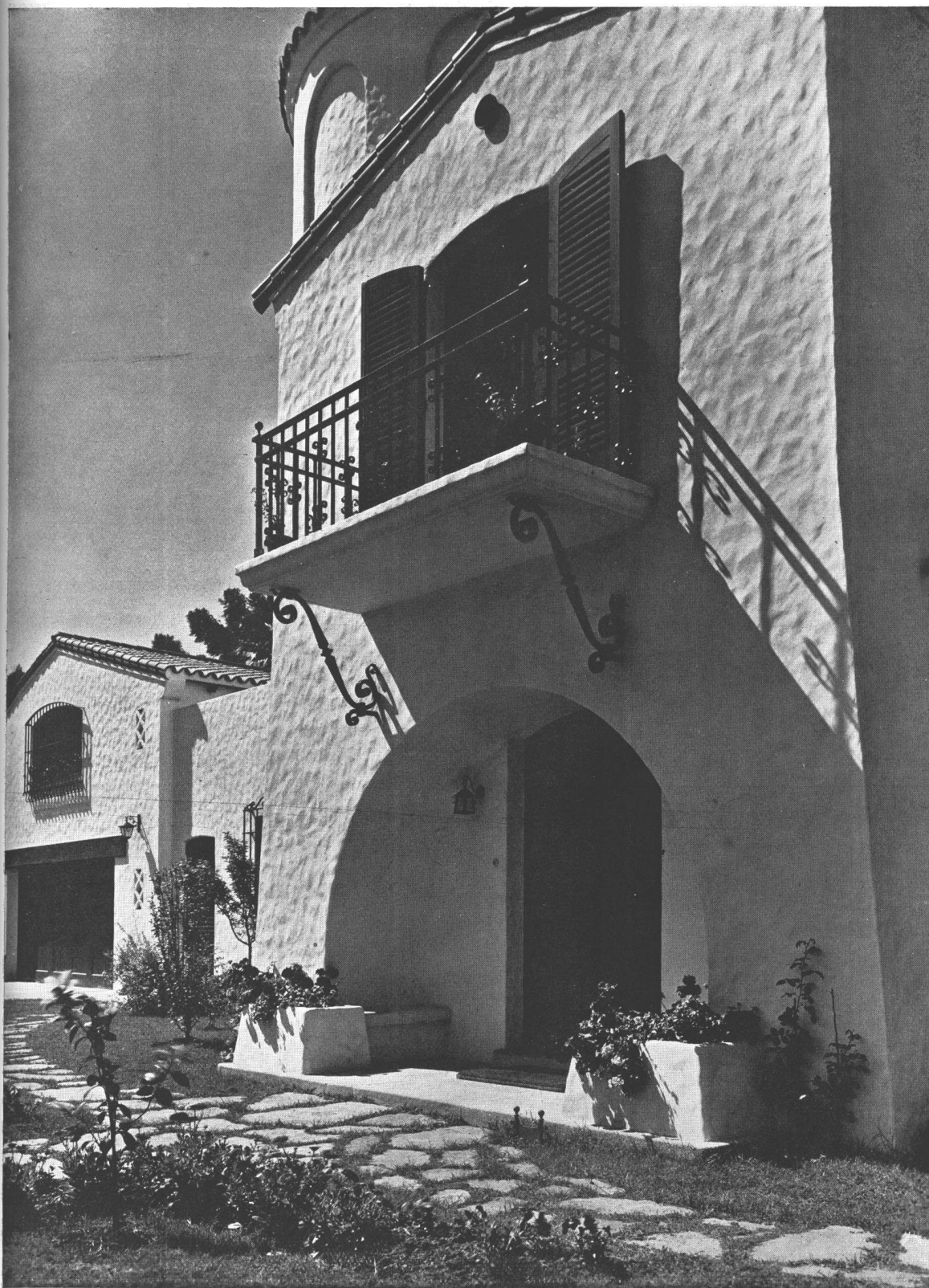
ARQ. A. G. SPANDRI. Vivienda particular en San Isidro; detalle de fachada.
