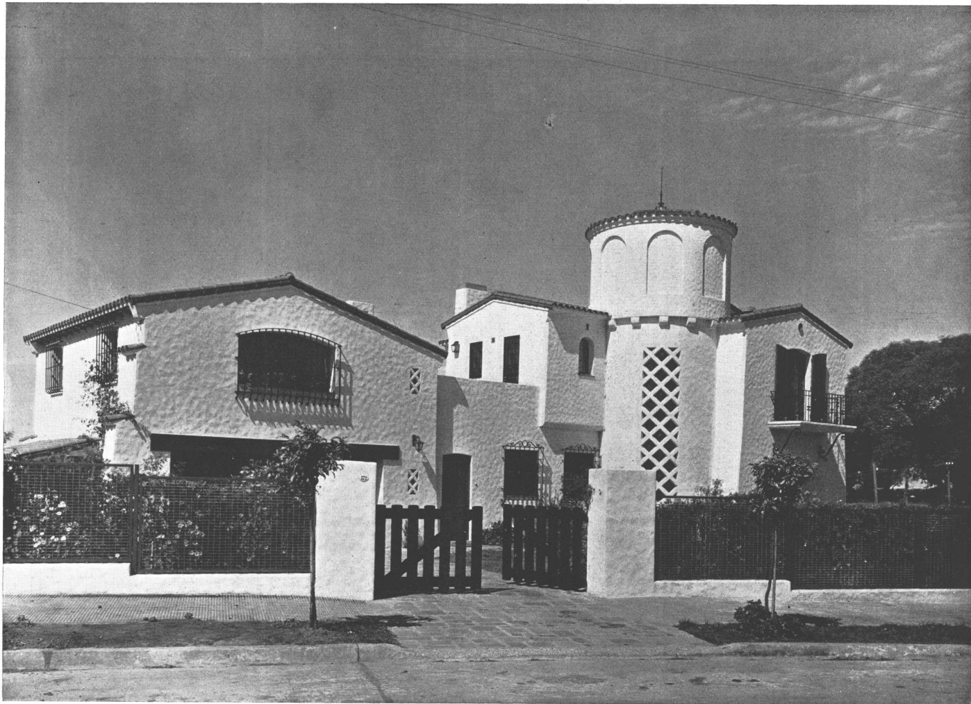
ARQ. A. G. SPANDRI. Vivienda particular en San Isidro; la casa vista desde la entrada y las plantas.
