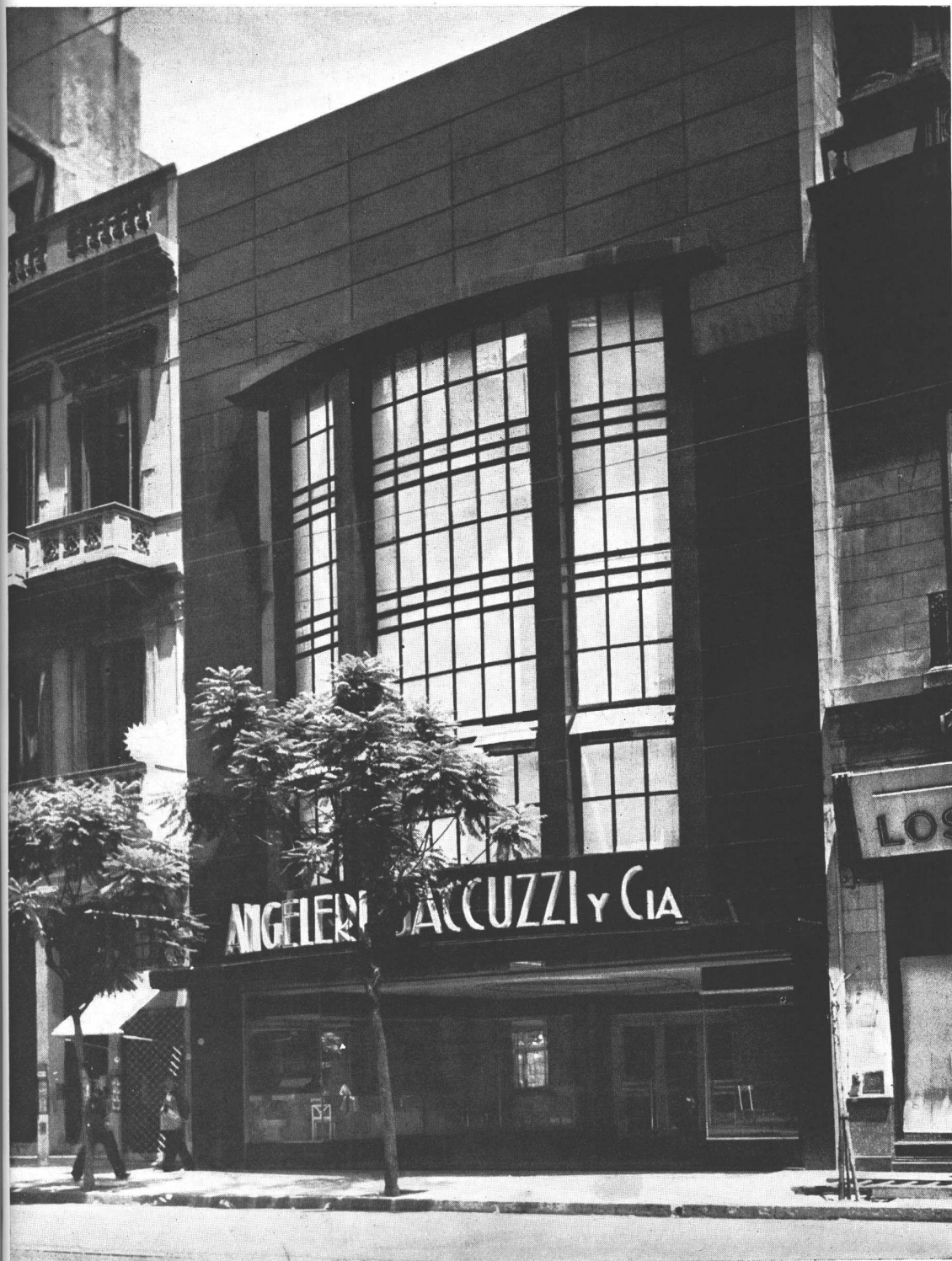
Perspectiva del frente principal del edificio, propiedad de la conocida firma de sanitarios, Angeleri Jacuzzi y Cia.
