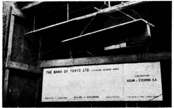
5. Momento en que se iza una de las vigas para el patio-jardín
