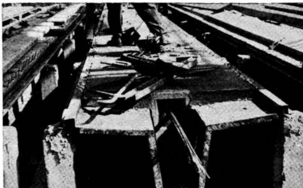
1. Se observan los extremos de tensado de las dos vainas y la arma dura de las alas. 2. Vigas estibadas en obra; las cortas son para alrededor del patio-jardín. 3. Véase la forma de la viga, la cabeza de anclaje y el sistema de moldeo. 4. Montaje del molde metálico.
