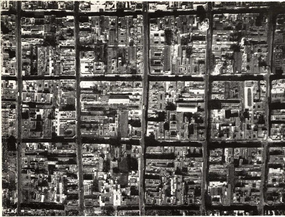
Fig. 2: Aerofotografía de un barrio de vivienda en Buenos Aires. Algunas ventanas abren sobre el tumulto de la calle; pero en el interior no hay ni patios suficientes ni jardines. Es la oscuridad absoluta. Foco de enfermedades.
